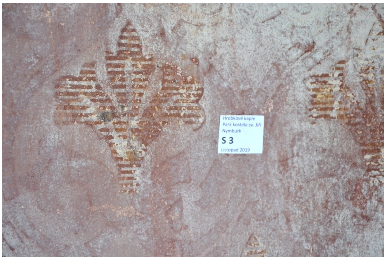
Sonda č. 3, soklová část, soutisková brokátová šablona pod recentním bílým nátěrem
