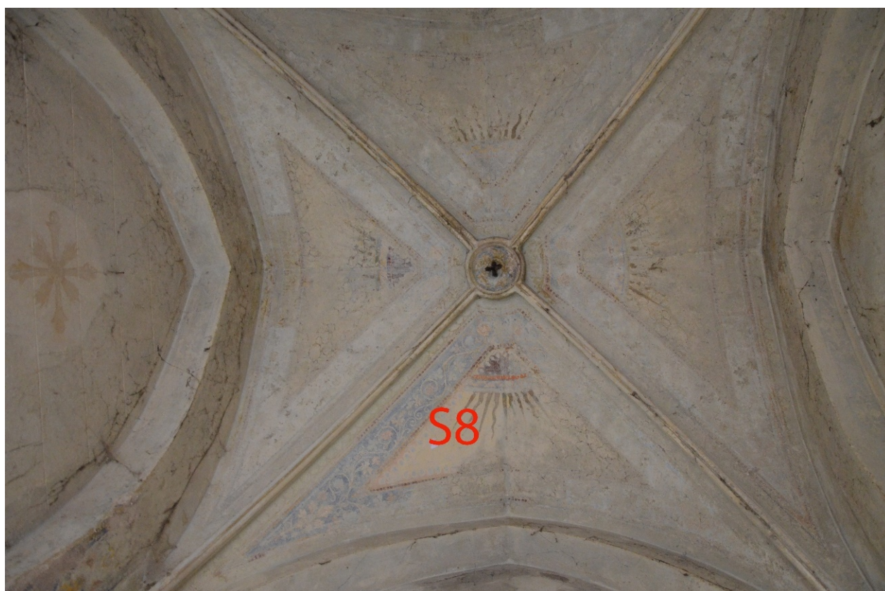
Strop kaple s označeným místem provedené odkryvné sondy
