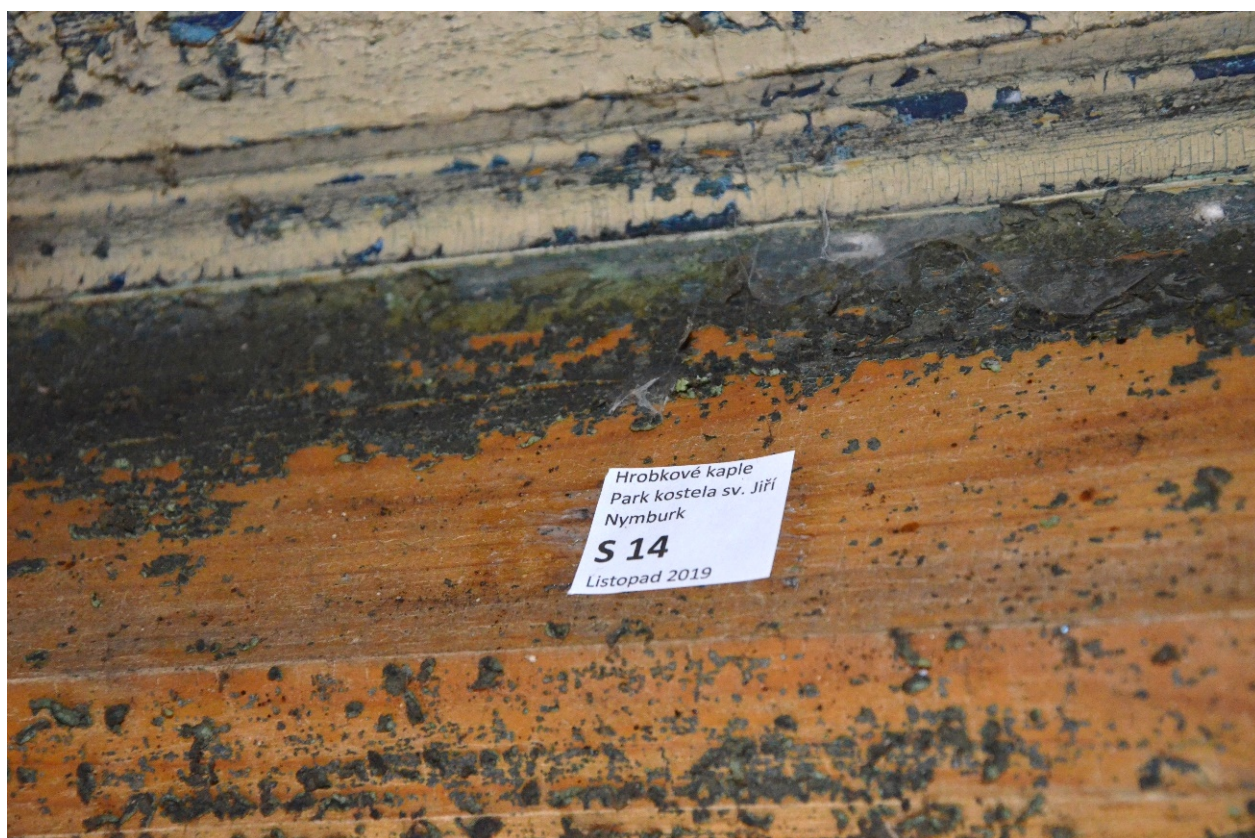
S14 na podhledu dřevěné stříšky – původní modrá barevnost degradovaná – zčernalá, na ní recentní žluto-okrový nátěr, shodné s nálezy S 12,15,16 A 17
