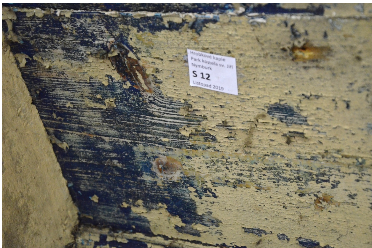
Sonda č 11 provedená na štukovém profilu římsy čelní stěny pod dřevěnou stříškou. Původní barevnost v khaki odstínu na ní recentní přemalba monochromním světle okrovo-žlutým nátěrem
