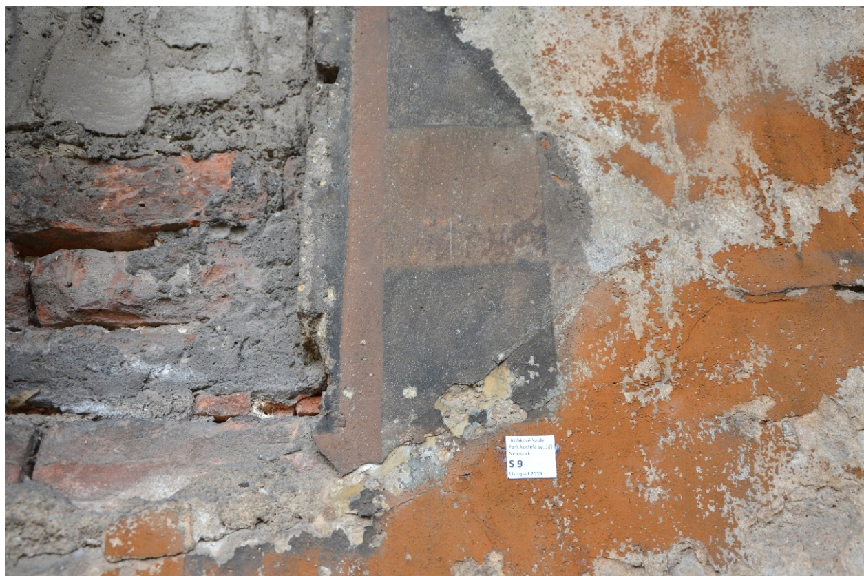
Sonda č. 9 na hranici nové opravy omítkovou vrstvou s vysokým podílem cementu – původní okrová barevnost světlejšího charakteru a nová, opravná barevnost cihlovým okrem
