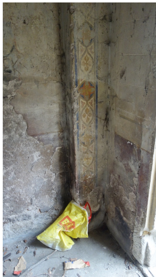
hrobka rodiny Tuzarových, poškozená omítka, malby a kamenný stůl, kapsy pro branku
