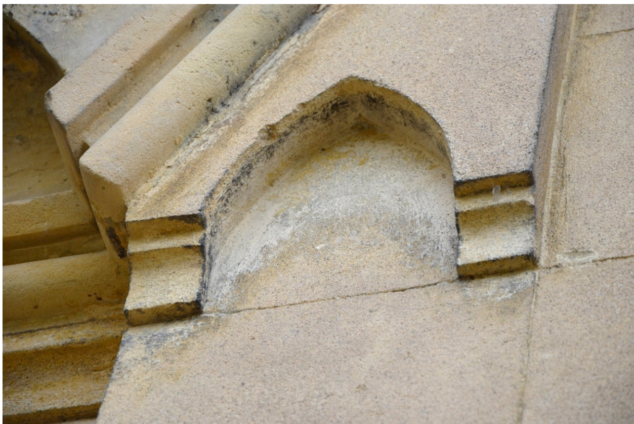
Snímek z čelní strany fasády – ukázky dochování monochromních nátěrů v bílé a okrové barevnosti ve spadových stínech profilů
