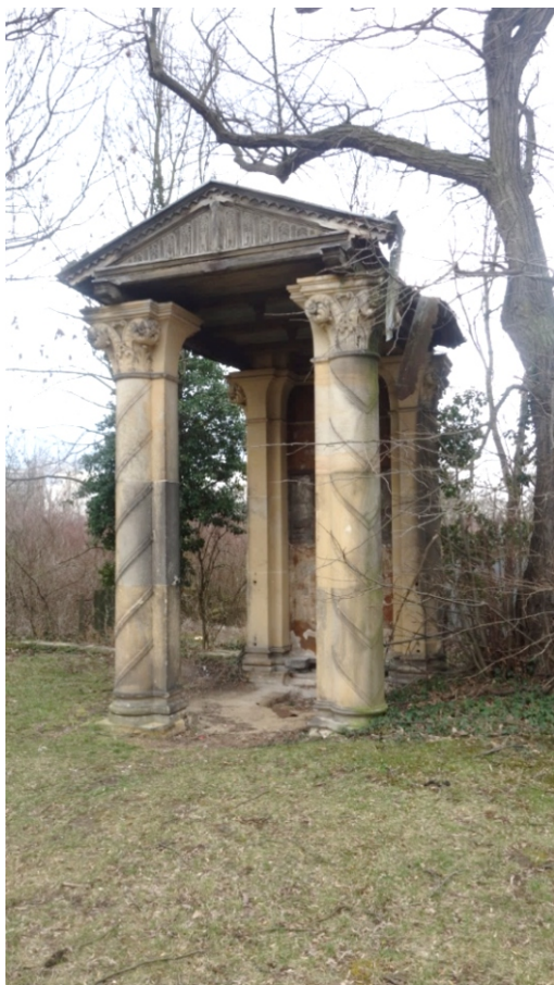
Celkový pohled na předmětnou stavbu
