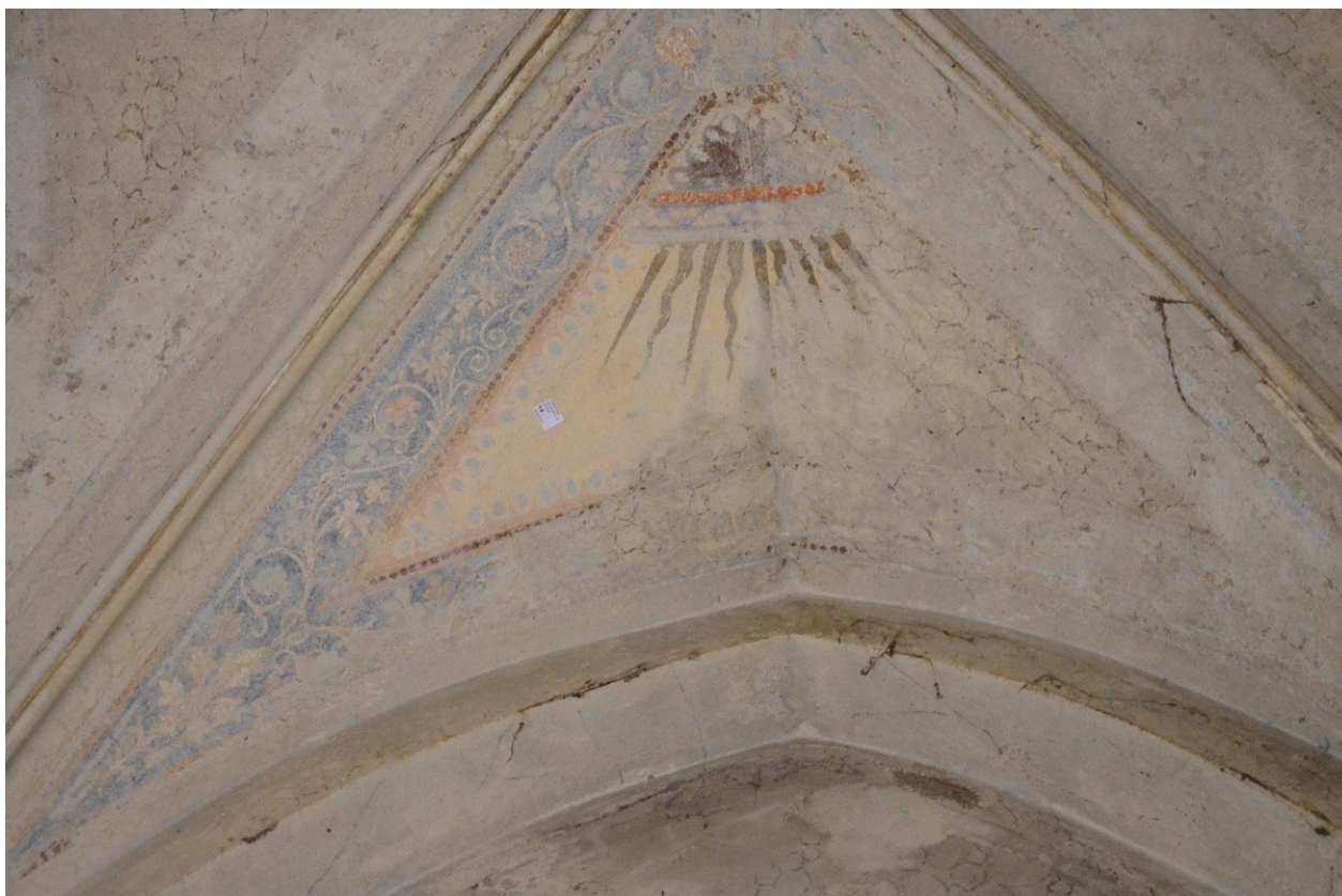
Sonda č. 8, provedená na klenbě kaple s dekorativními šablonovými malbami, ručně domalováno
