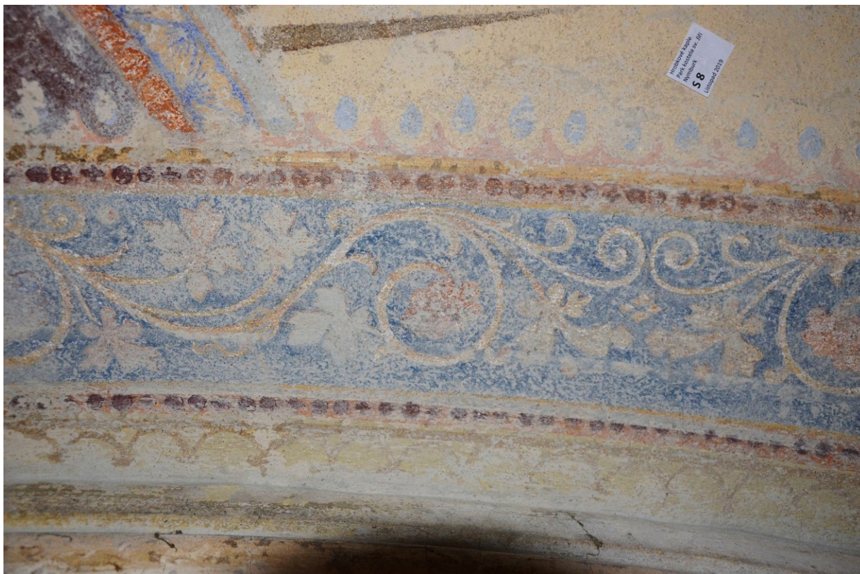
Sonda č. 8, provedená na klenbě kaple s dekorativními šablonovými malbami, ručně domalováno
