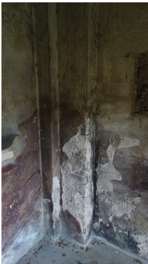
hrobka rodiny Tuzarových, poškozená omítka, malby a kamenný stůl, kapsy pro branku
