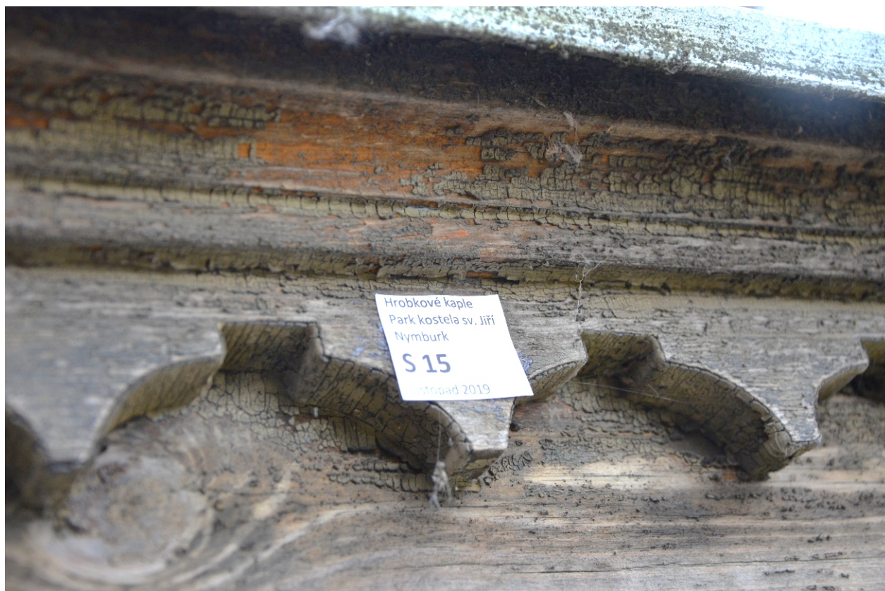
Sonda č. 15 provedená na zvětralém dřevěném čelním štítu střechy – dřevo, fragmenty modré barevnosti spojené s recentním žluto – okrovým nátěrem (krakelující) – shodné s nálezy S 12,14,16 A 17
