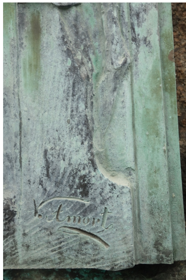
detail bronzové desky, koroze, biologické napadení, signatura autora, signatura slévárny,
