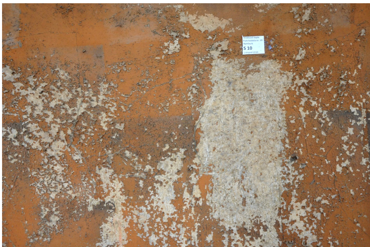
Sonda č. 9 na hranici nové opravy omítkovou vrstvou s vysokým podílem cementu – původní okrová barevnost světlejšího charakteru a nová, opravná barevnost cihlovým okrem
