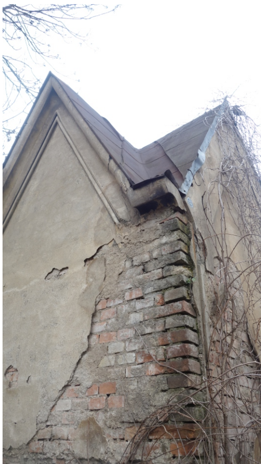
chybějící a degradovaná omítka
