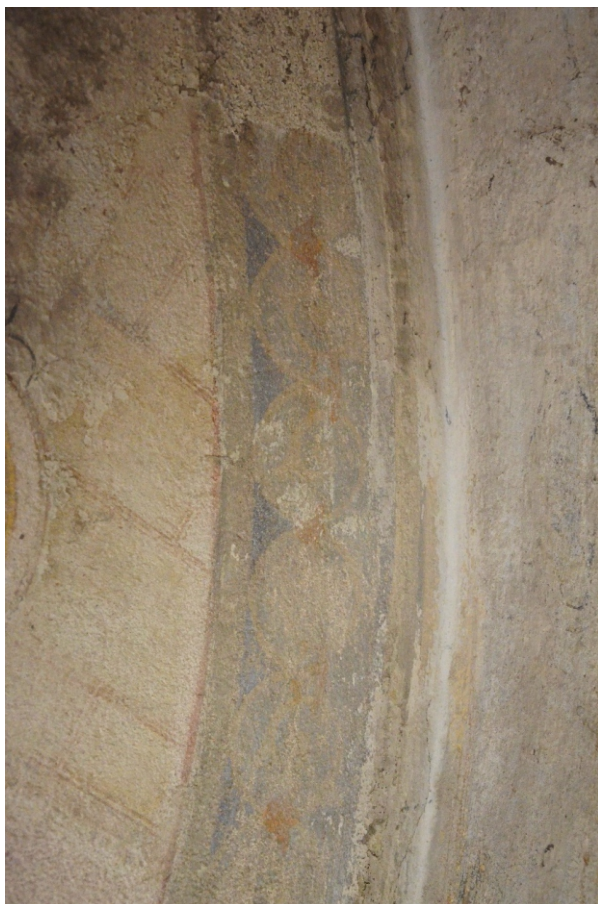
Okraj rozsáhlé odkryté sondy S7 s šablonovým dekorem lemujícím figurální výjev na čelní stěně
