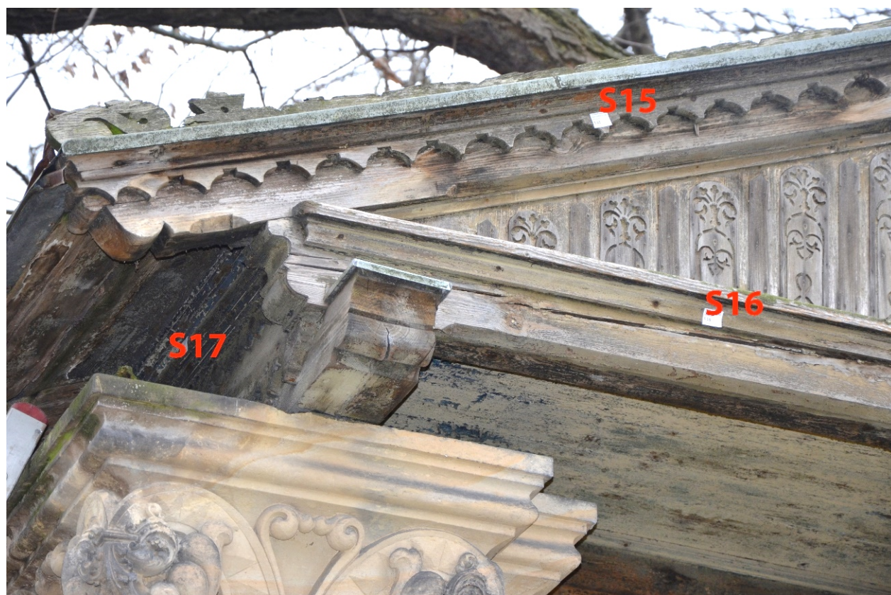
Zakreslení provedené sondáže na dřevěném štítu stříšky
