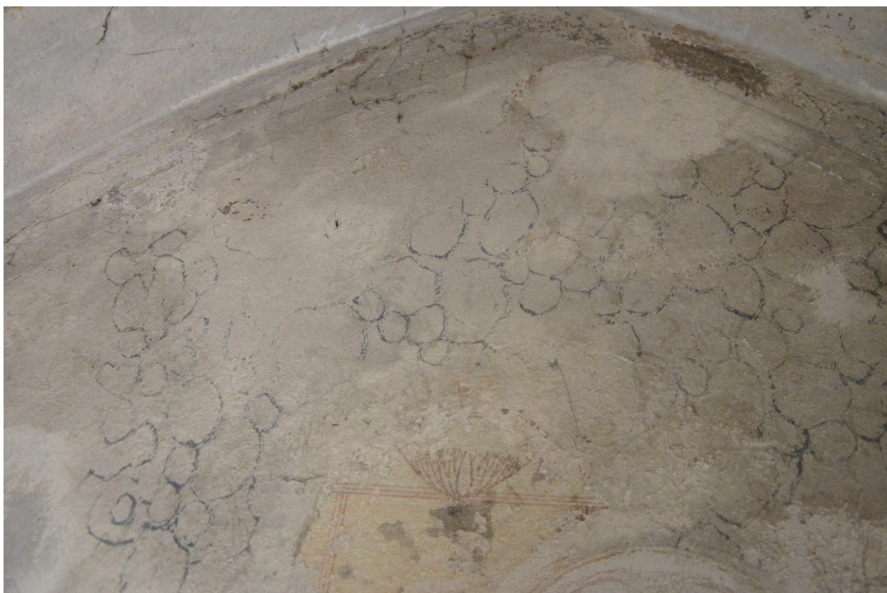
Snímky recentní barevné vrstvy – monochromní bílá barevnost podkladu s malovaným modrým žilkováním mramoru
