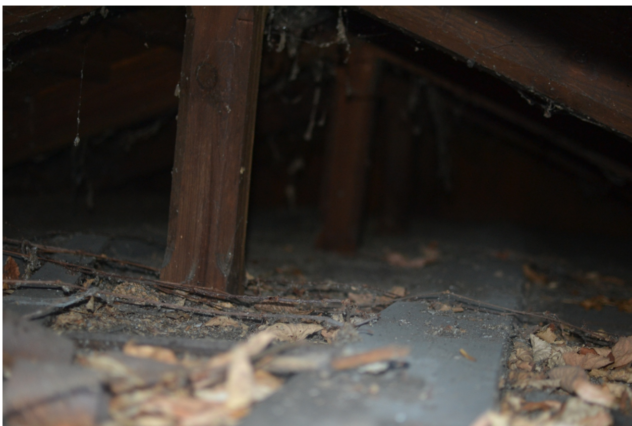
dřevěná stříška, vnitřní konstrukce
