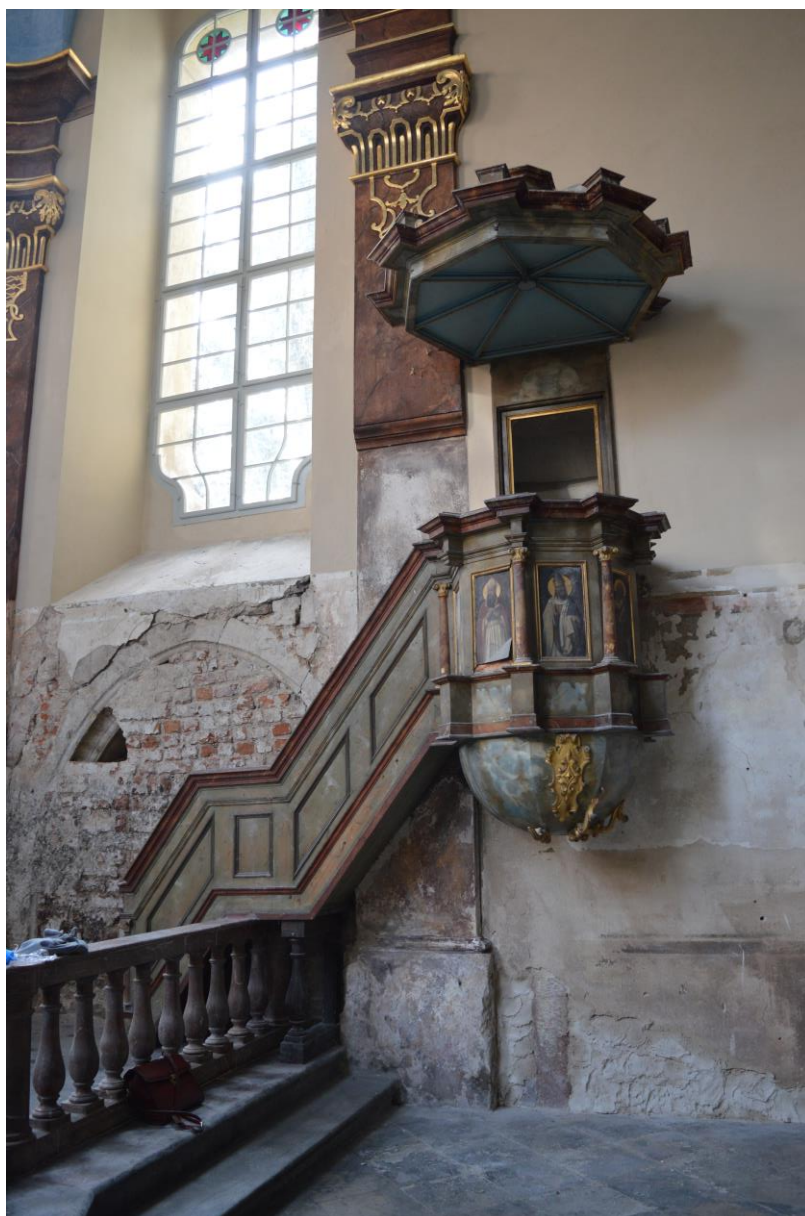
Kazatelna, současný stav
