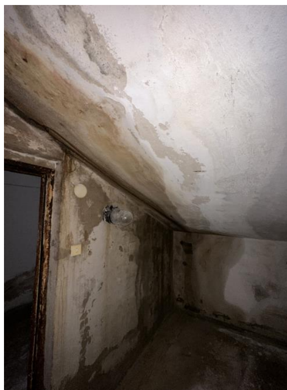
Obr. 32 Poškození omítky v prostoru schodiště do 1. PP
