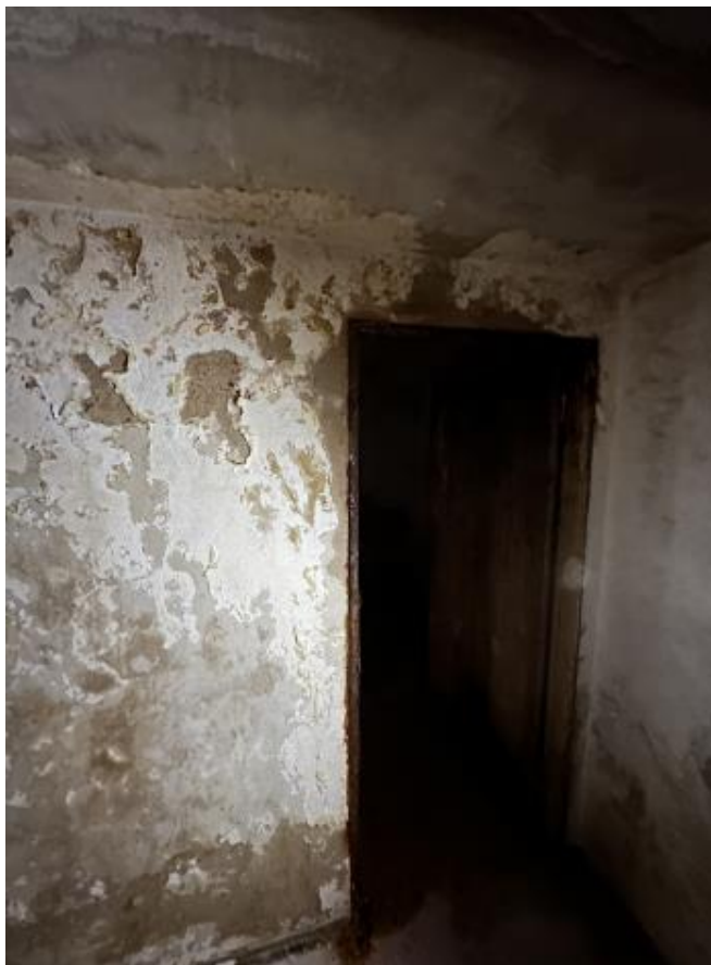
Obr. 28 Poškození omítky suteréních prostor vlivem vlhkosti
