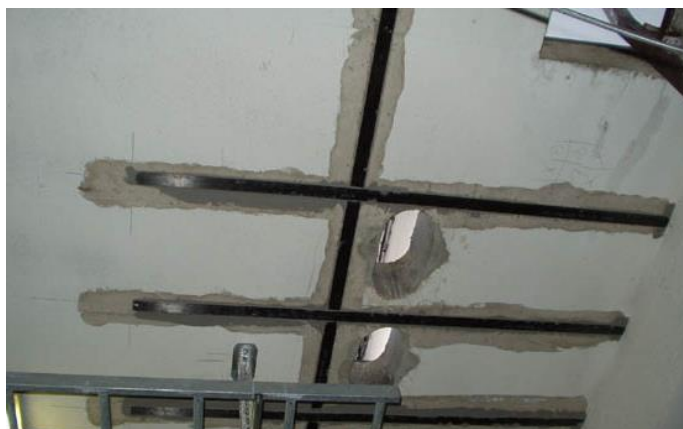
Ukázka aplikace uhlíkových lamel kolem otvorů v desce
