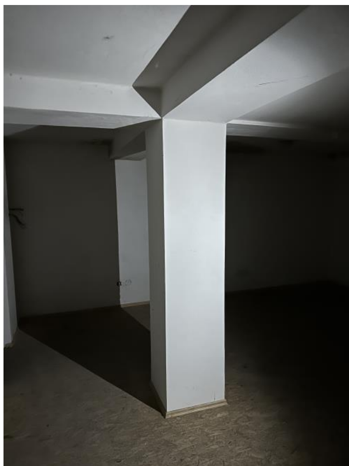
Obr. 6 Sloup a průvlaky v suterénu
