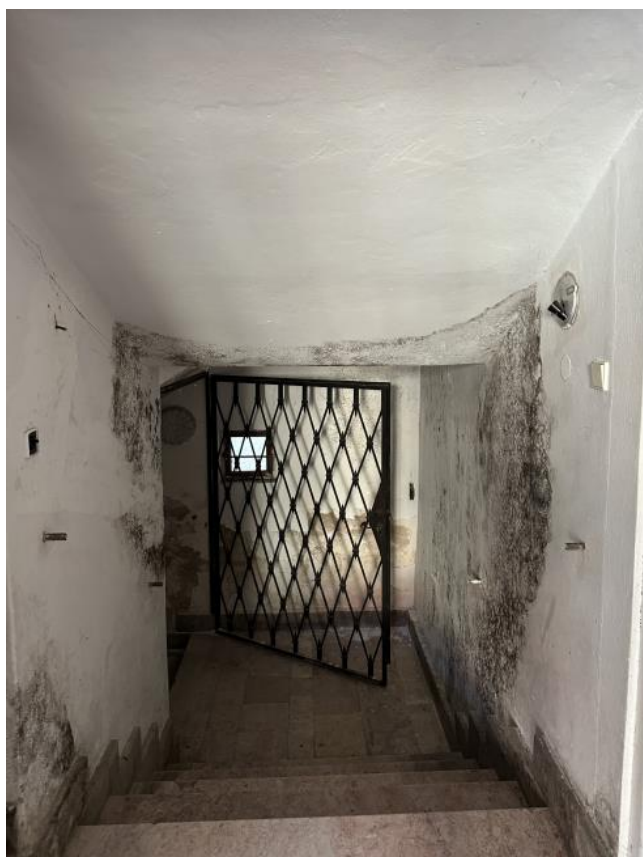
Obr. 29 Poškození omítky v prostoru schodiště do 1. PP
