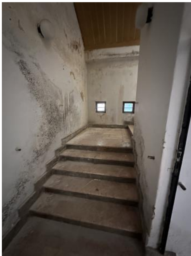
Obr. 31 Poškození omítky v prostoru schodiště do 1. PP
