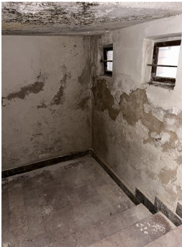
Obr. 30 Poškození omítky v prostoru schodiště do 1. PP
