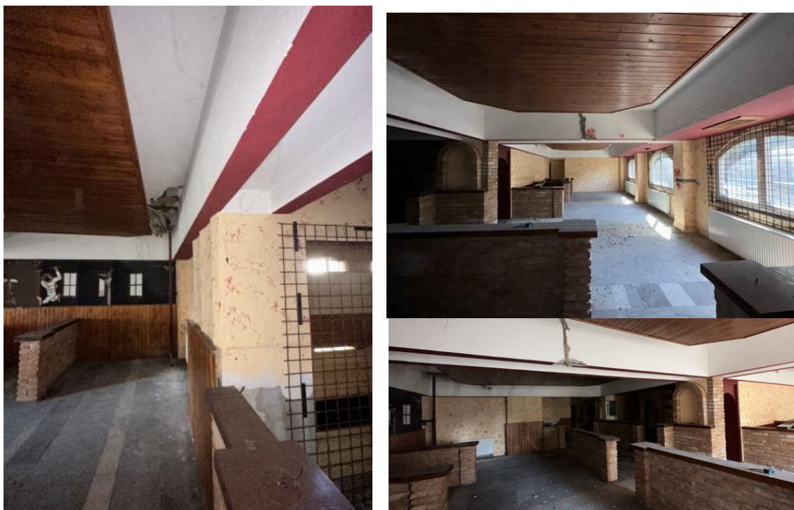
Obr. 5 Průvlaky nad přízemím
