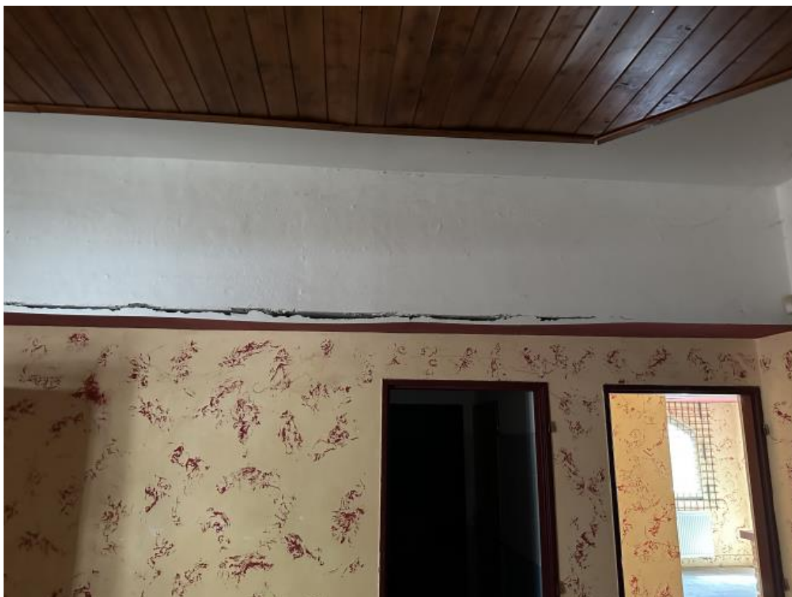
Obr. 34 Vodorovná trhлина v přízemí na styku výplňového zdiva a ŽB konstrukce
