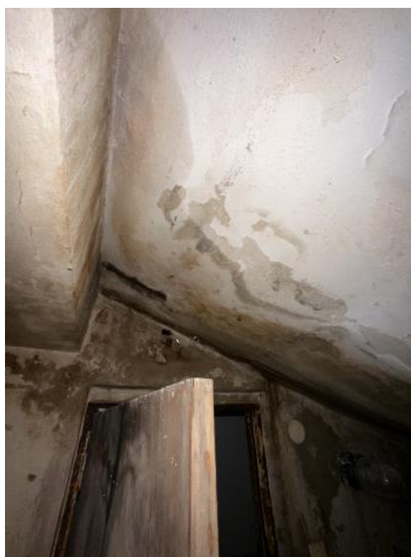
Obr. 32 Poškození omítky v prostoru schodiště do 1. PP
