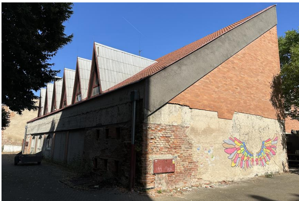
Obr. 22 Degradace fasády – jižní a východní fasáda
