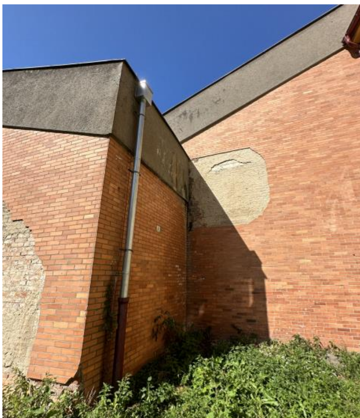
Obr. 26 Degradace východní fasády
