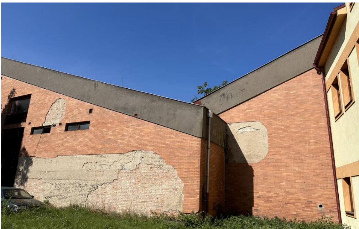
Obr. 26 Degradace východní fasády
