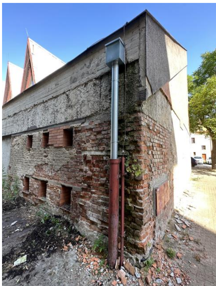
Obr. 22 Degradace fasády – jižní a východní fasáda
