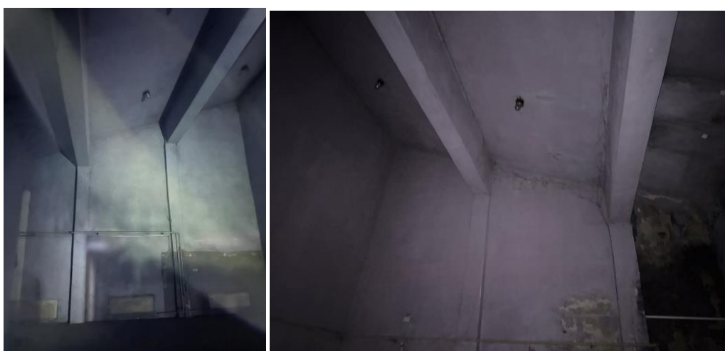
Obr. 8 Masivní střešní průvlaky nad 2. patrem
