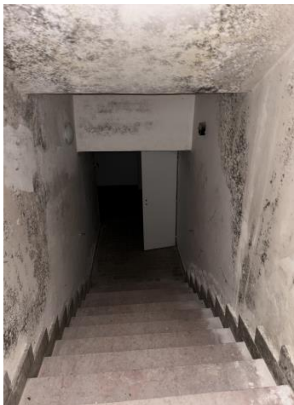
Obr. 32 Poškození omítky v prostoru schodiště do 1. PP
