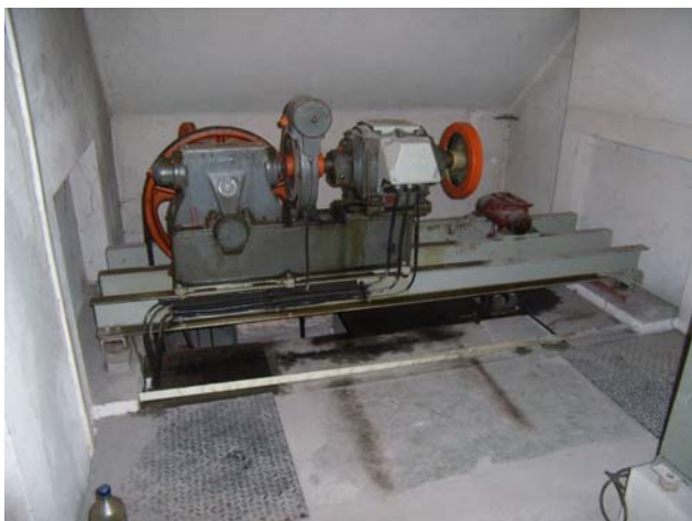
pohled do strojovny výtahu, původní usazení stroje
