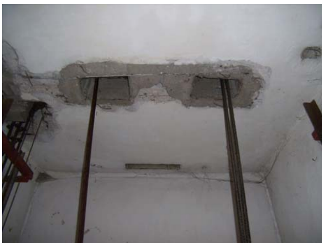
původní otvory ve stropu šachty
