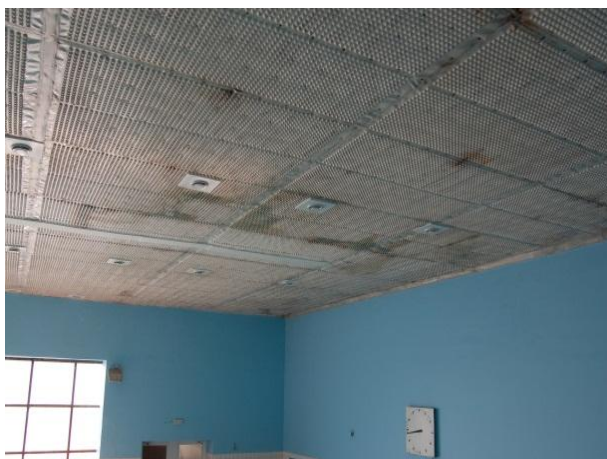
Foto č.101: Přívodní koncové elementy bazénu ve stropě
