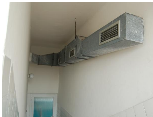
Foto č.100: Ocelové potrubí v prostoru schodiště
