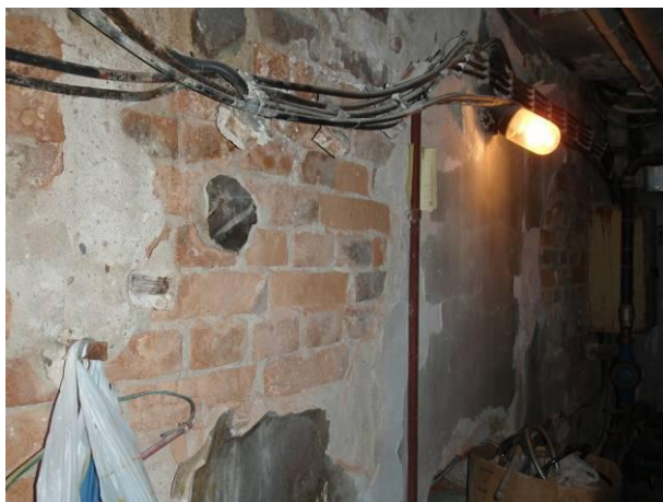
Foto č.78: Špatně upevněná elektroinstalace
