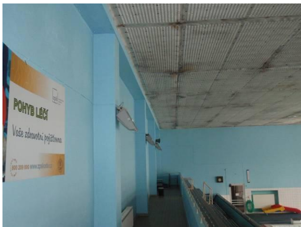
Foto č.90: Nepřímé osvětlení haly, odrazné plochy jsou zprohýbané a zkorodované, čímž je vážně narušena účinnost nepřímého osvětlení
