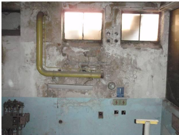
Foto č.76: Nevhodné svítidlo a nevhodné přístroje
