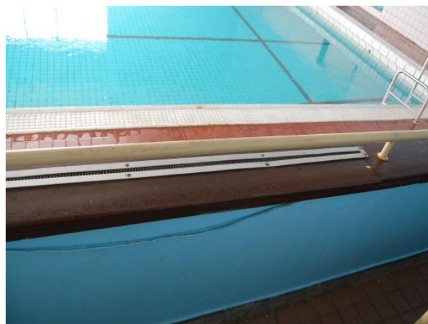
Foto č.102: Přívodní koncové elementy bazénu v zábradlí
