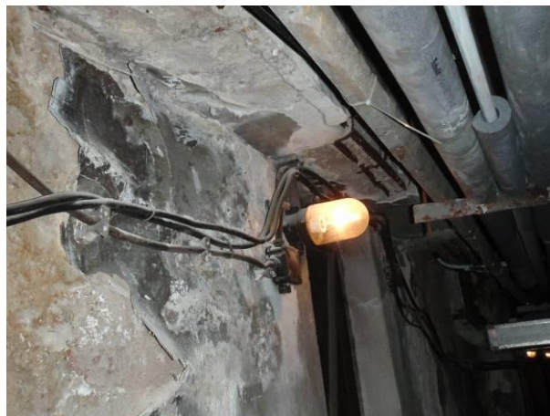
Foto č.83: Elektrická instalace není řádně upevněna
