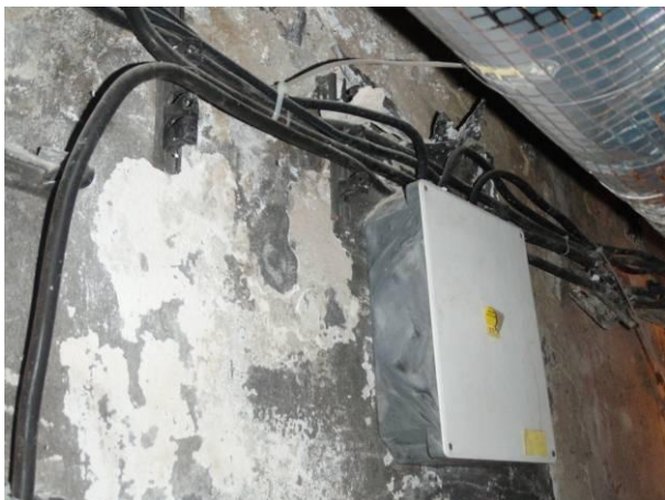
Foto č.82: Elektrická instalace není řádně upevněna
