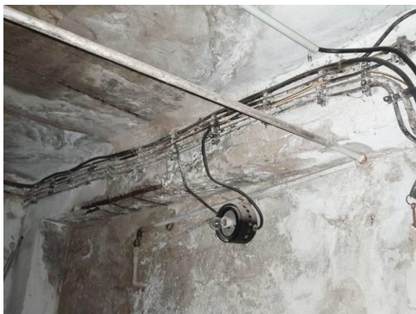
Foto č.80: Nekompletní svítidlo, v současné době se nevyrábí
