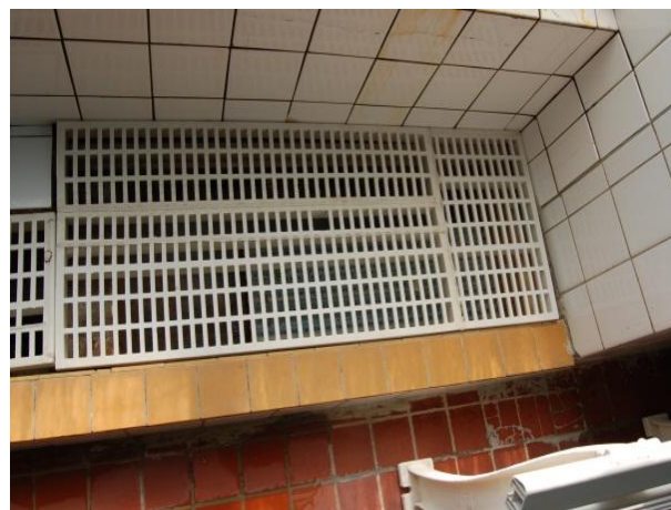
Foto č.104: Odvodní koncové elementy bazénové haly
