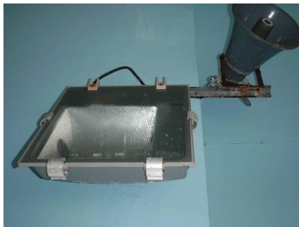
Foto č.91: Svítidla upevněná na zkorodovaných konstrukcích
