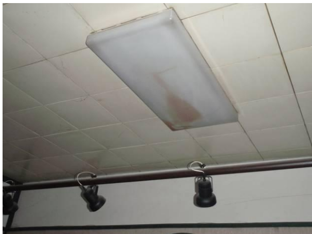
Foto č.88: Poškozené zářivkové svítidlo – nebezpečí zahoření
