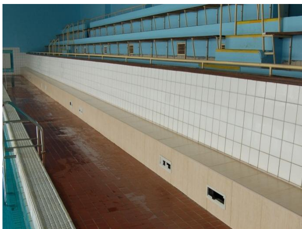
Foto č.103: Odvodní koncové elementy bazénové haly
