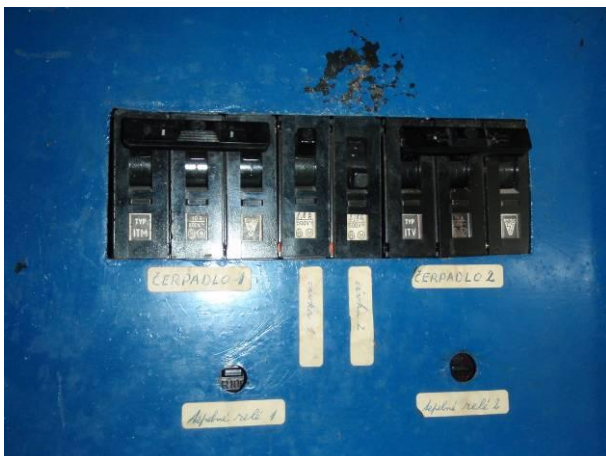
Foto č.84: Rozvaděč s přístroji, které se již nevyrábějí a které mají již dnes nevyhovující vlastnosti – malá zkratová odolnost
