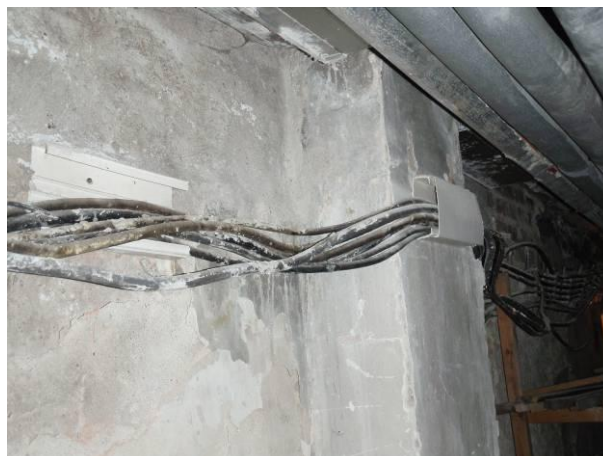
Foto č.85: Dodatečné úpravy elektroinstalace, které nerespektují zatížitelnost kabelů a způsoby upevnění
