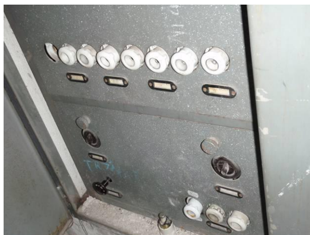
Foto č.87: Rozvaděč s přístroji, které se již nevyrábějí a jsou za svou životností
