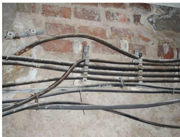
Foto č.93: Různě upravovaná nedostatečně upevněná elektroinstalace
