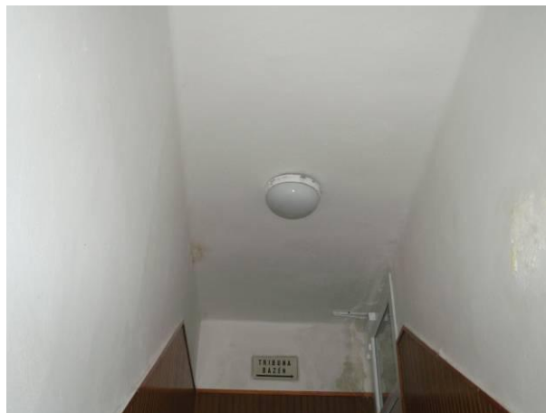
Foto č.89: Nevhodné svítidlo do prostoru s vlhkostí
