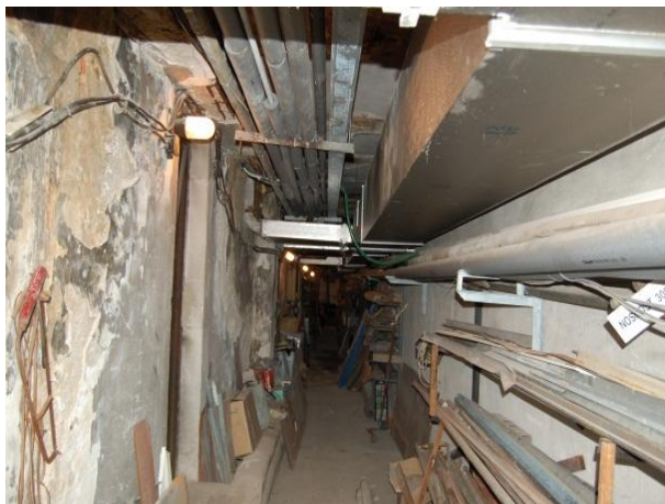
Foto č.97: Vedení VZT potrubí v 1. podzemním podlaží
