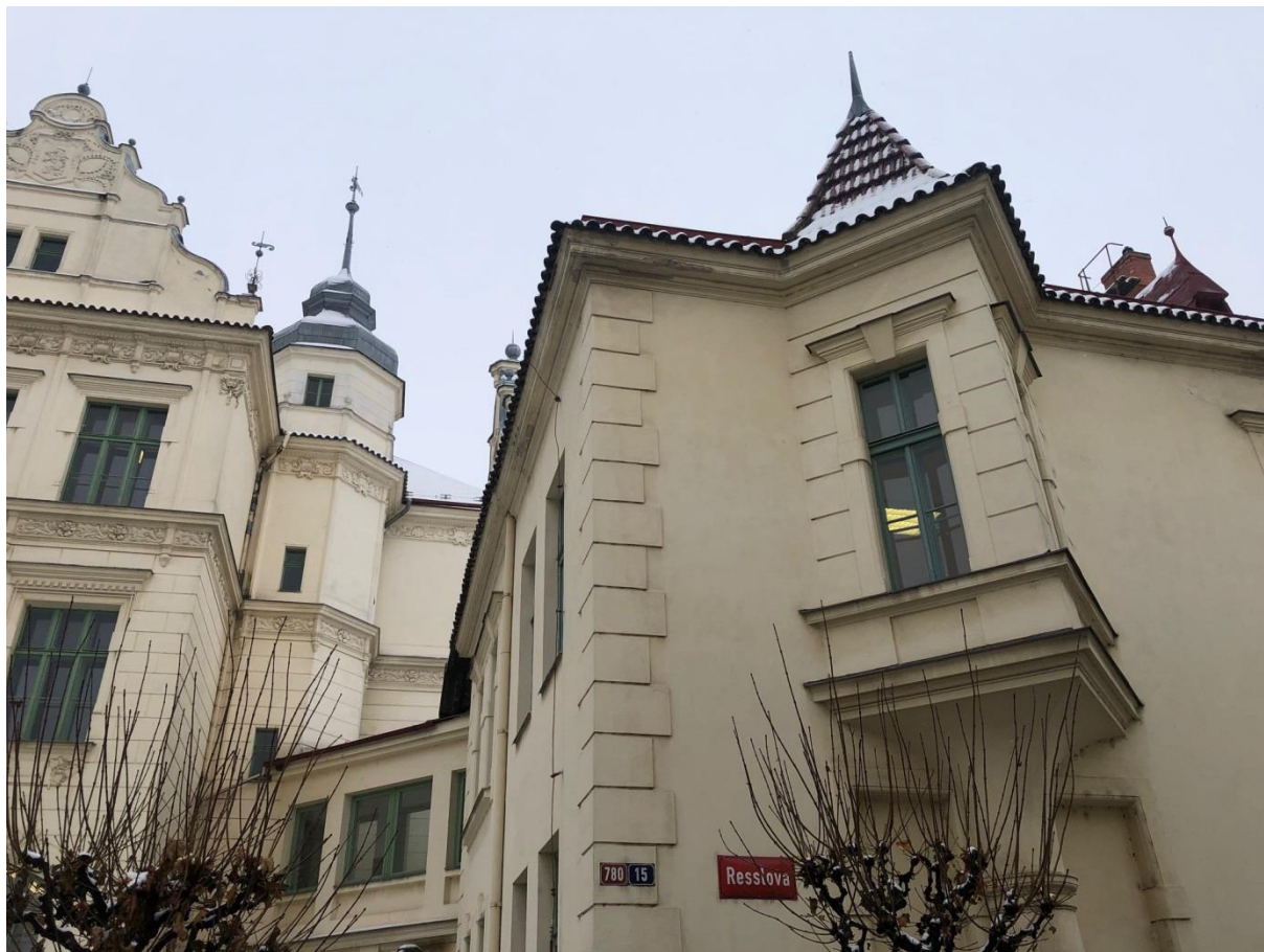
Foto č.1 –pohled JV
