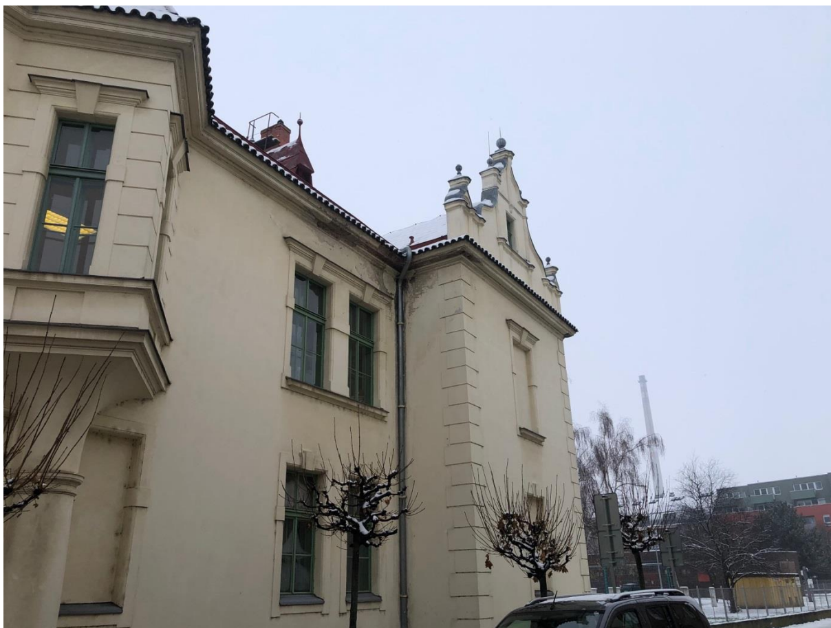
Foto č.3 – pohled JV
