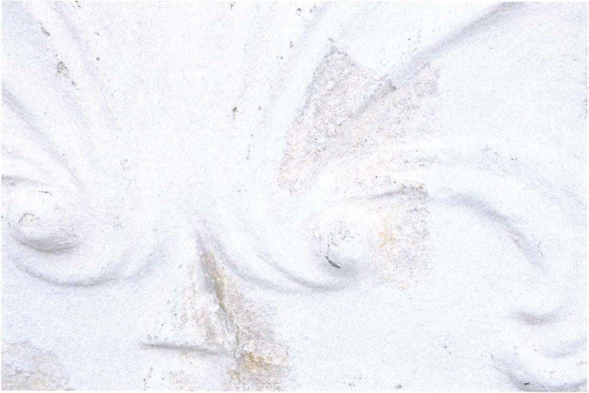
Obr.5/ Detail plastické výzdoby. Vystouplé prvky byly světlejší oproti pozadí. Povrch plastických prvků je poškozen.
