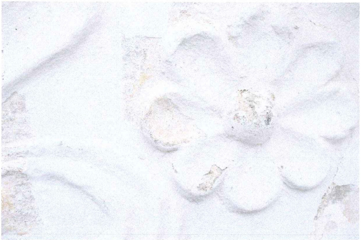
Obr.10/ Detail plastické výzdoby. Vystouplé prvky byly světlejší oproti okrovému pozadí, barva plastický prvků byla v odstínu lomená bílá (lomená do teplejšího tónu).
