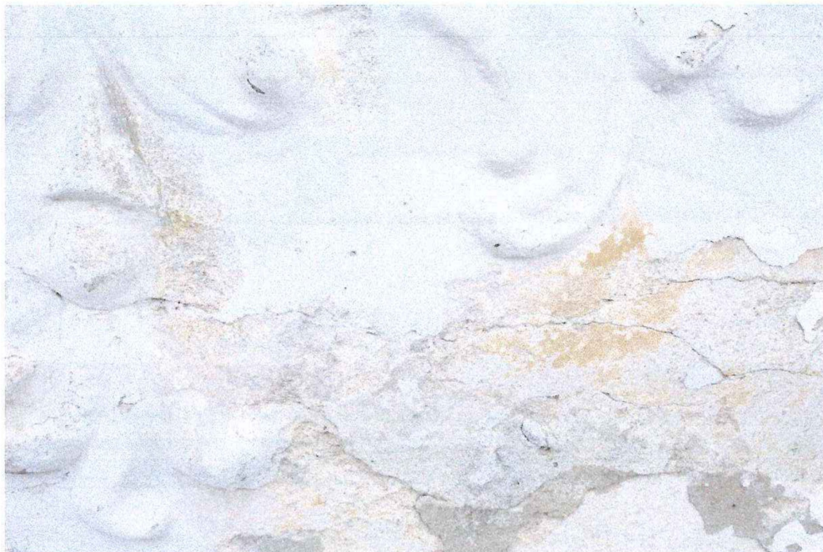
Obr.3/ Detail v místě plastické výzdoby, jsou viditelné praskliny, vysprávka v omítkové vrstvě a výrazné barevné fragmenty mladšího nátěru v barvě okru.
