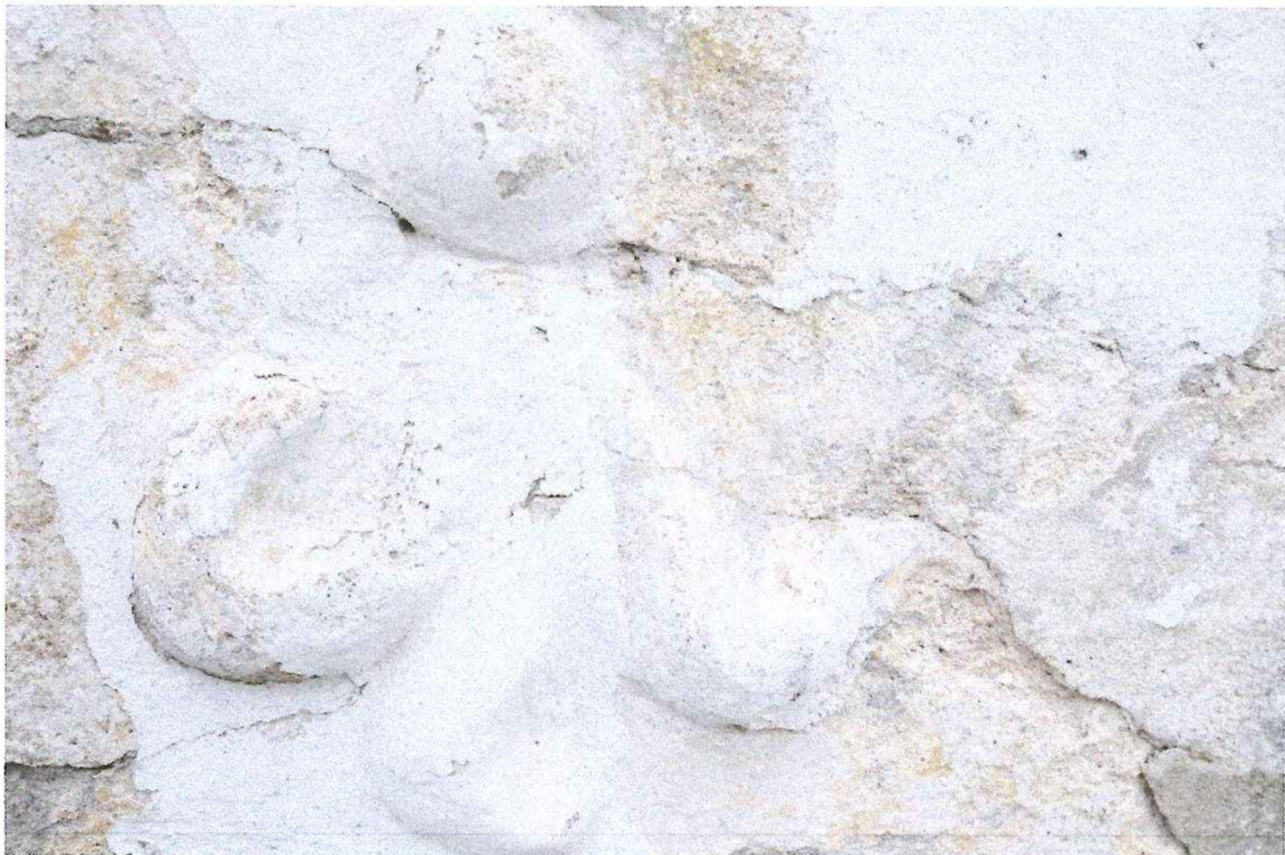
Obr.6/ Detail v místě plastické výzdoby s viditelnými poškozeními – trhliny mladší omítkové vysprávkou. Šipkou je označen velmi malý fragment zelené barvy.
