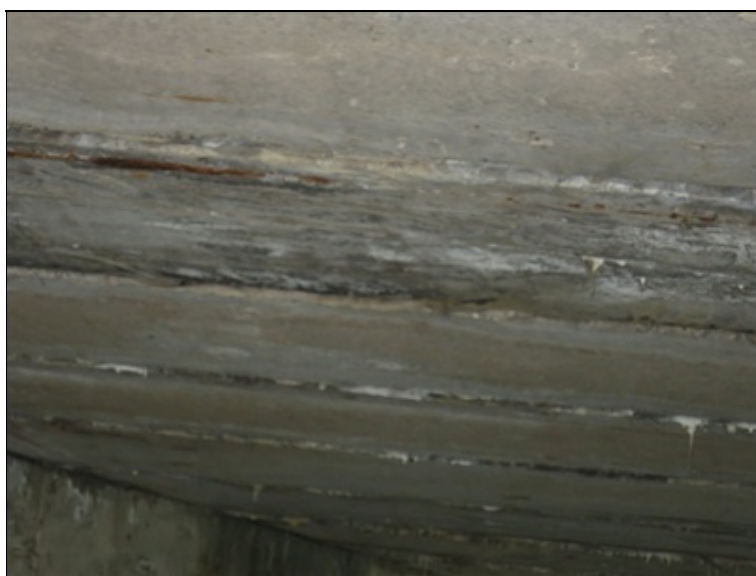
stopy po intenzivním průsaku z dutiny nosníku
