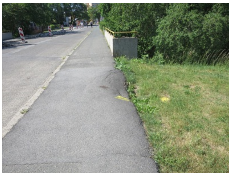
deformace chodníku na předmostí
