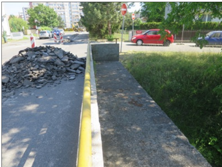
degradace betonu římsy
