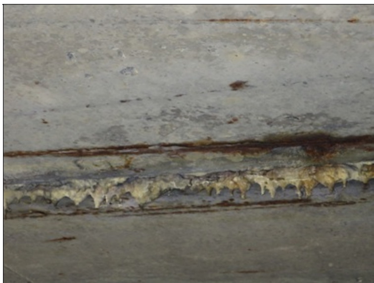
korozí konstrukční výztuže
