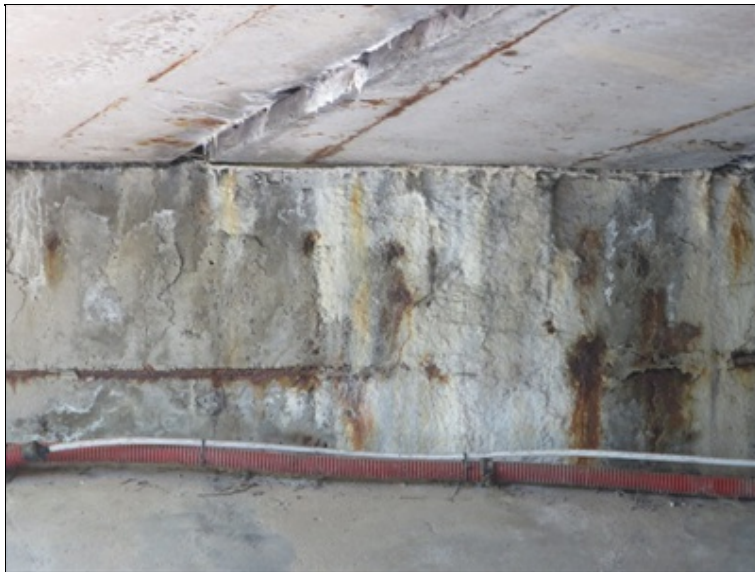
degradace betonu opěry v místě průsaku
