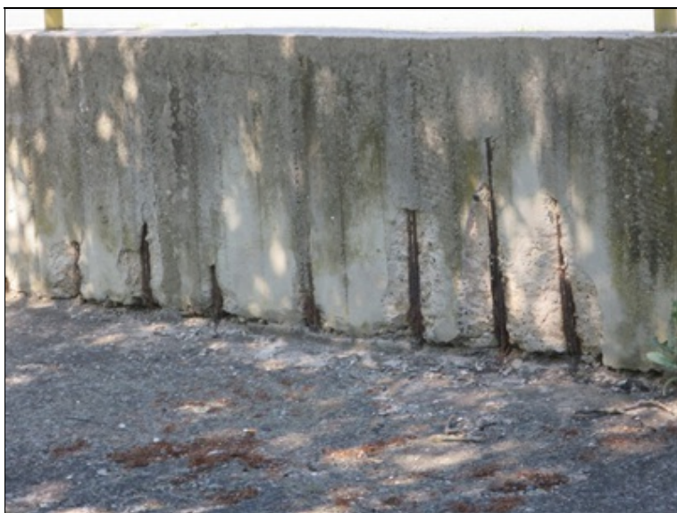
korozí obnažené výztuže na rubu římsy
