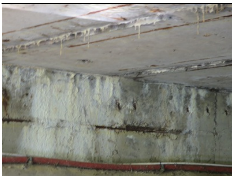
koroze obnažené výztuže na líci opěry v místě průsaku
