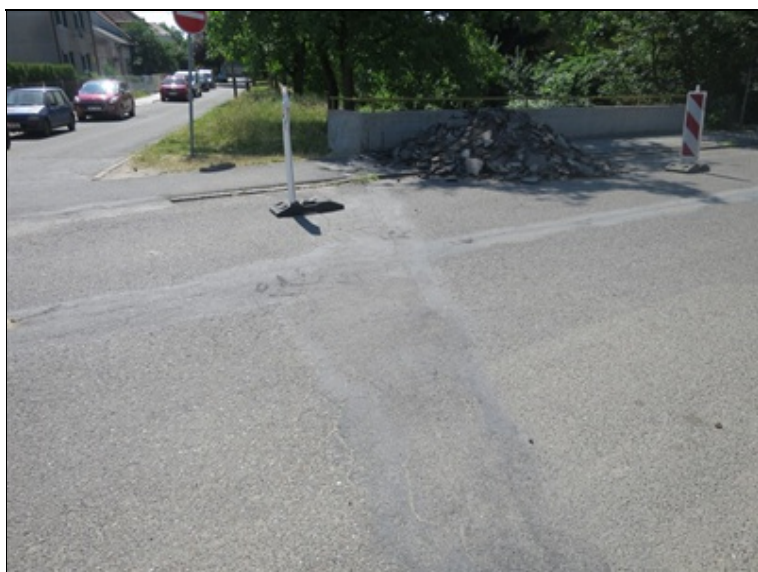
oprava poruch krytu vozovky v oblasti dilatační spáry
