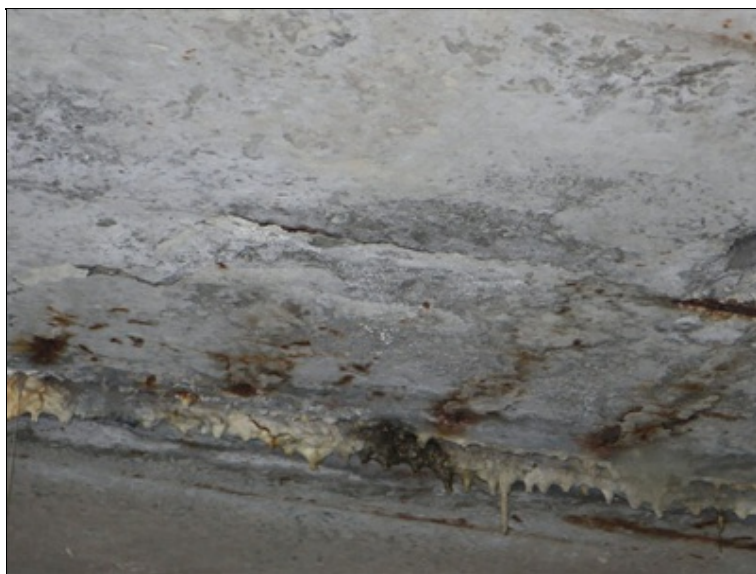
separace krycí vrstvy nad korodující konstrukční výztuží
