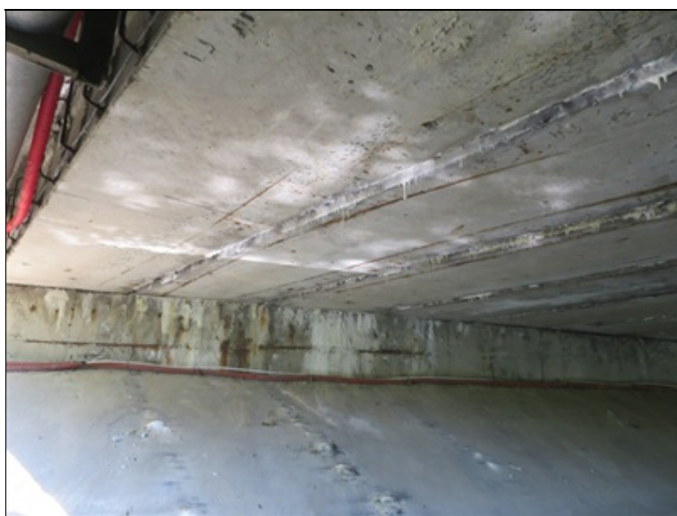
stopy po průsacích s výluhy pojiva na líci opěry
