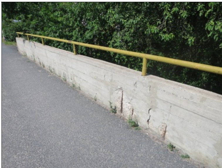
koroze obnažené výztuže na líc zábradelní zídky
