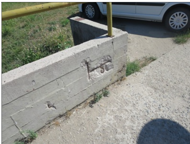
detail poruch zábradlí
