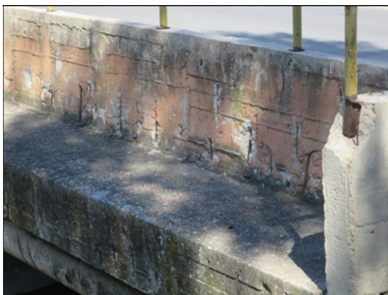
koroze výztuže zábradelní zídky v místě kotvení do římsy
