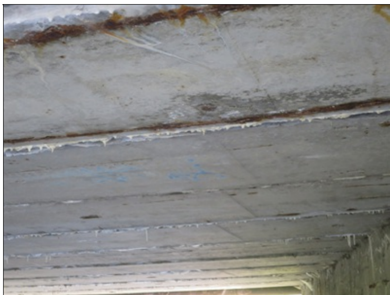
stopa po lokálním průsaku z dutiny nosníku
