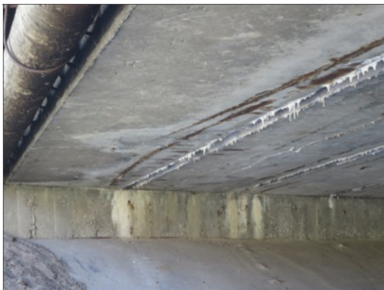
stopy po průsaku s výluhy pojiva na líci opěry v místech spar mezi nosníky
