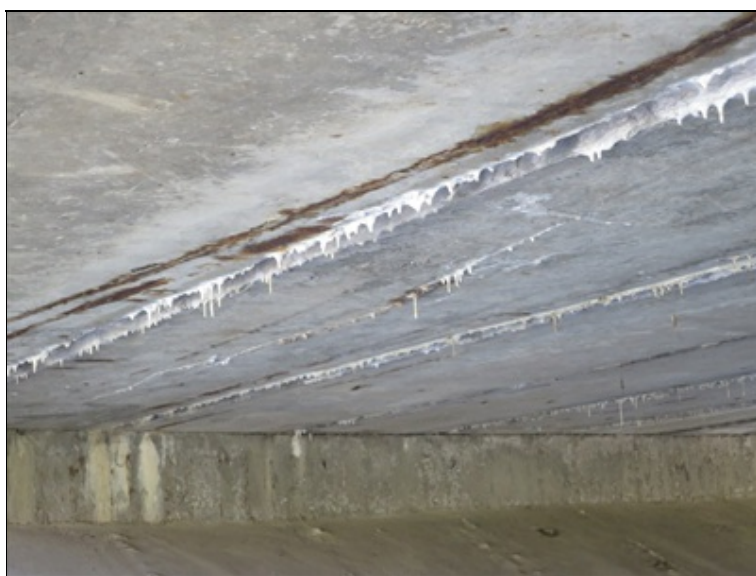
průsaky s výluhy pojiva sparami mezi nosníky i trhlinami, které kopírují trajektorii předpínací výztuže
