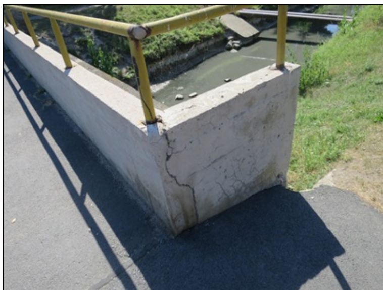
trhlina v zábradelní zídce
