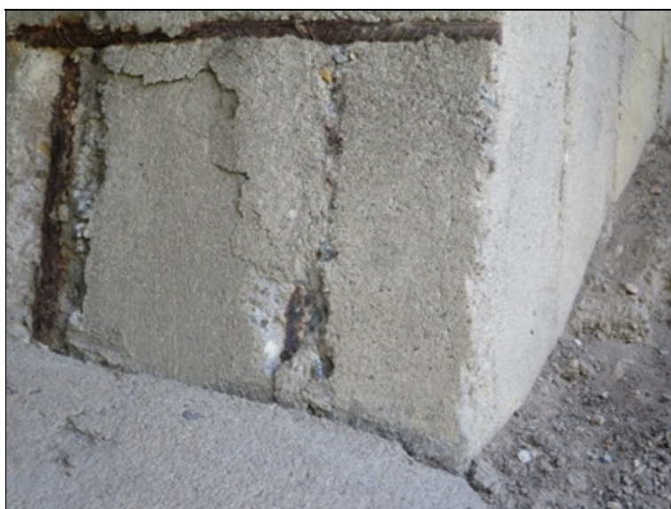
separace krycí vrstvy nad korodující výztuží u opěry
