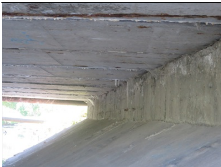
uložení nosníků na opěru
