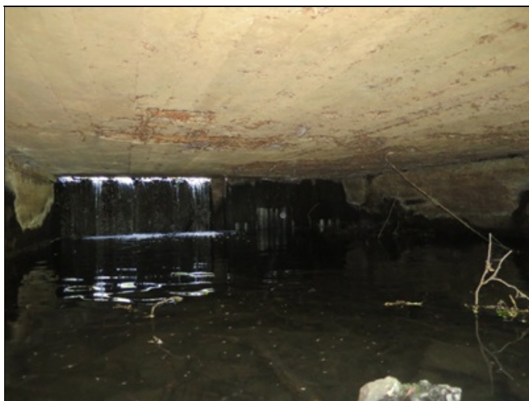
koroze obnažené výztuže v oblasti odpadlé krycí vrstvy
