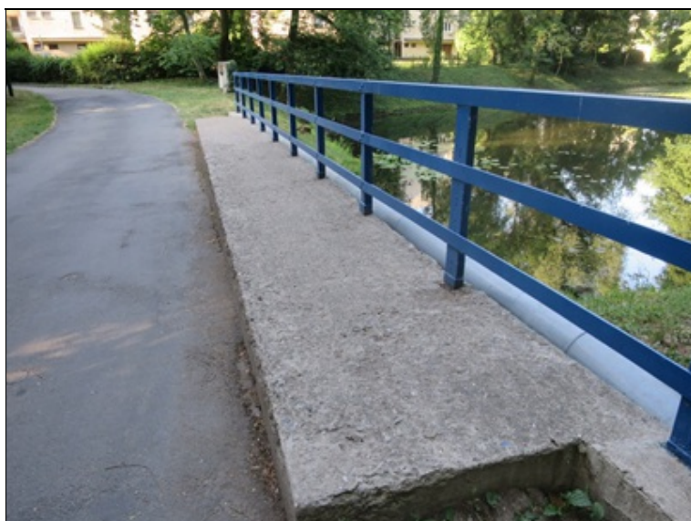
beton chodníku degraduje
