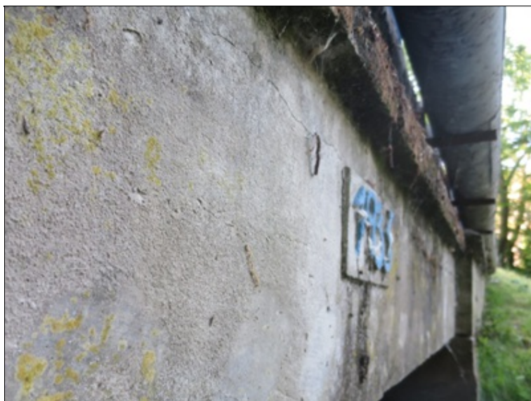
beton římsy degraduje
