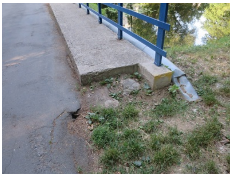
na předmostí nemá chodník návaznost, kaverna v krytu vozovky
