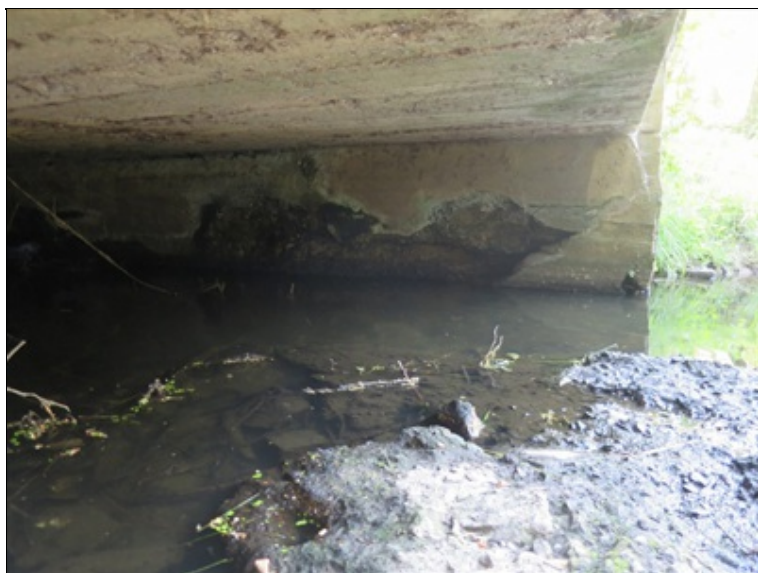
hloubková degradace betonu opěry
