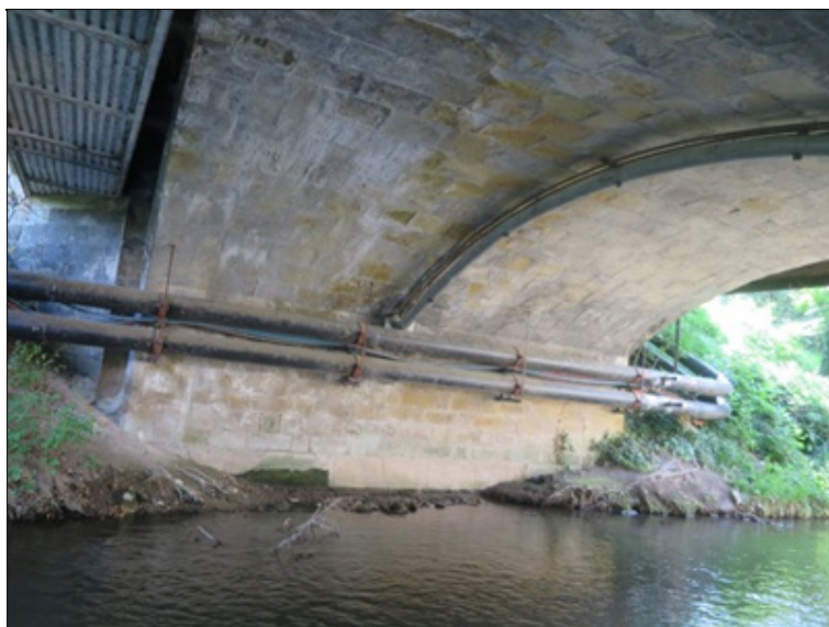
podhled klenbového pasu, intenzivní stopy po průsacích s výluhy pojiva
