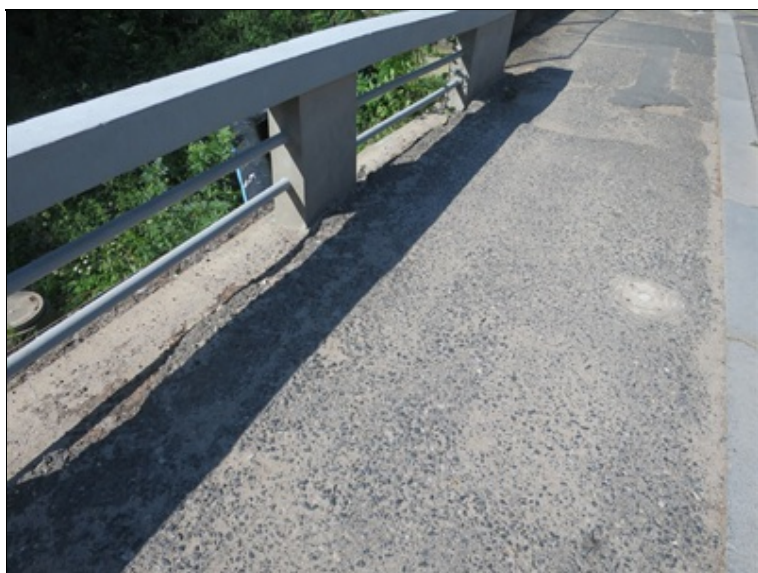
deformace krytu chodníku, degradace betonu římasy
