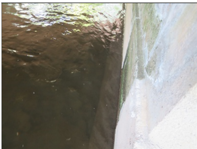
částečně podemletý dřík pravobřežní opěry
