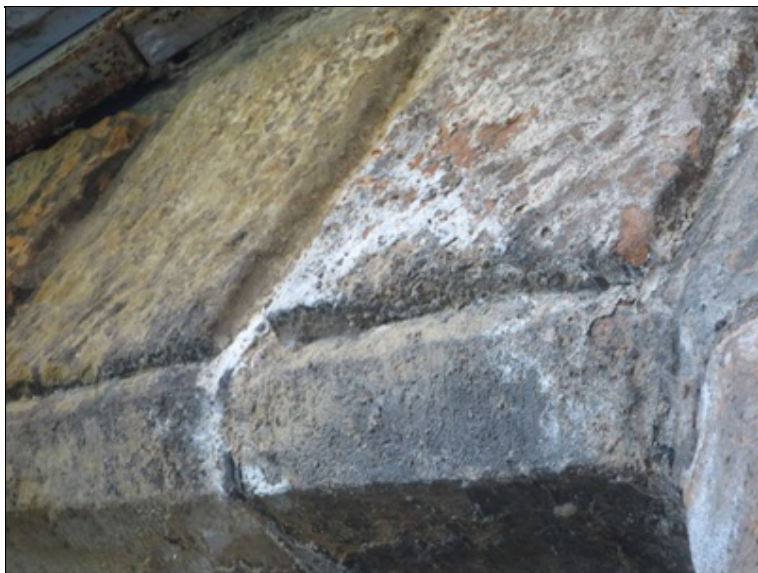
detail degradace kamene zdiva klenbového pasu v patě u opěry
