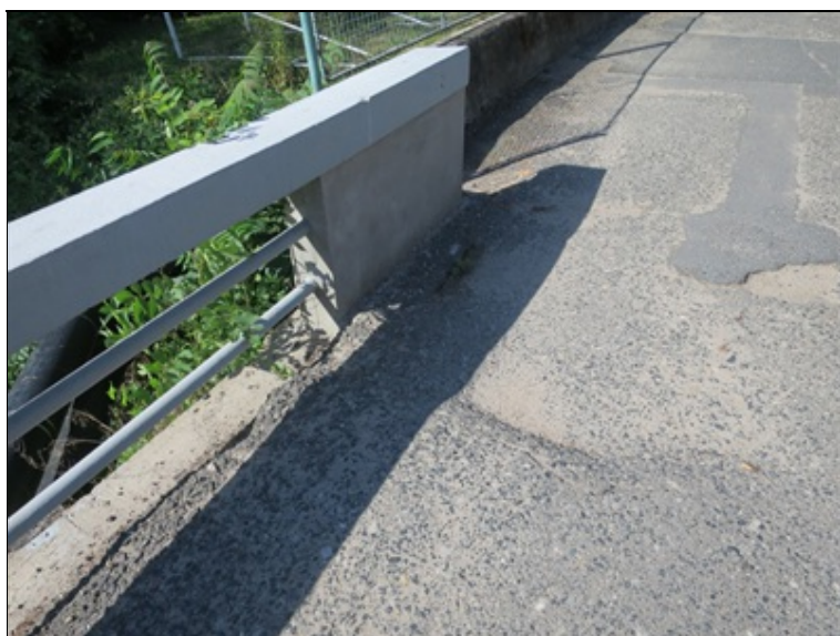
hloubková degradace krytu chodníku na předmostí
