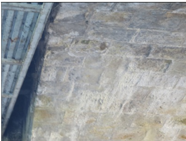
detail průsaků s výluhy pojiva
