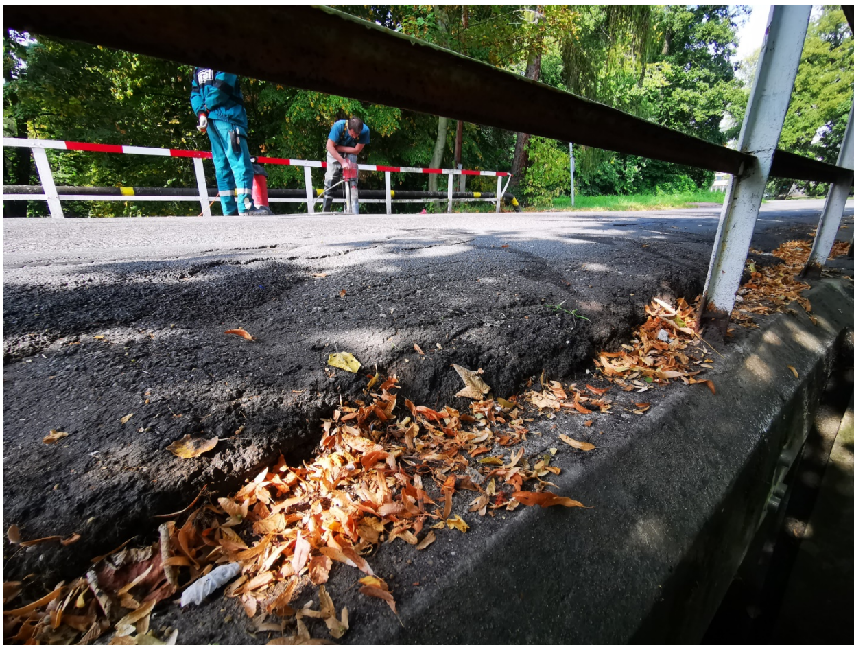
Obrázek č. 5: Pohled na most z návodní strany – silná vrstva asfaltobetonu – až 230 mm.
