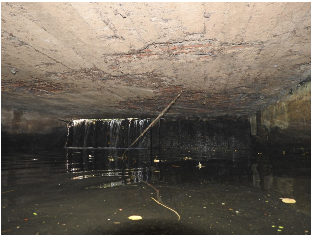
Obrázek č. 6: Rozsáhlé plochy na dolním líci nosné konstrukce poškozené odpadlou krycí vrstvou a extrémní korozí výztuže.
