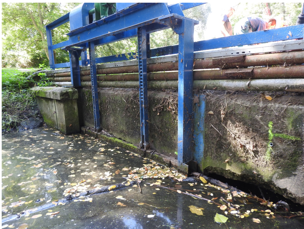
Obrázek č. 3: Pohled na nosnou konstrukci z návodní strany s mechanismem stavidla.
