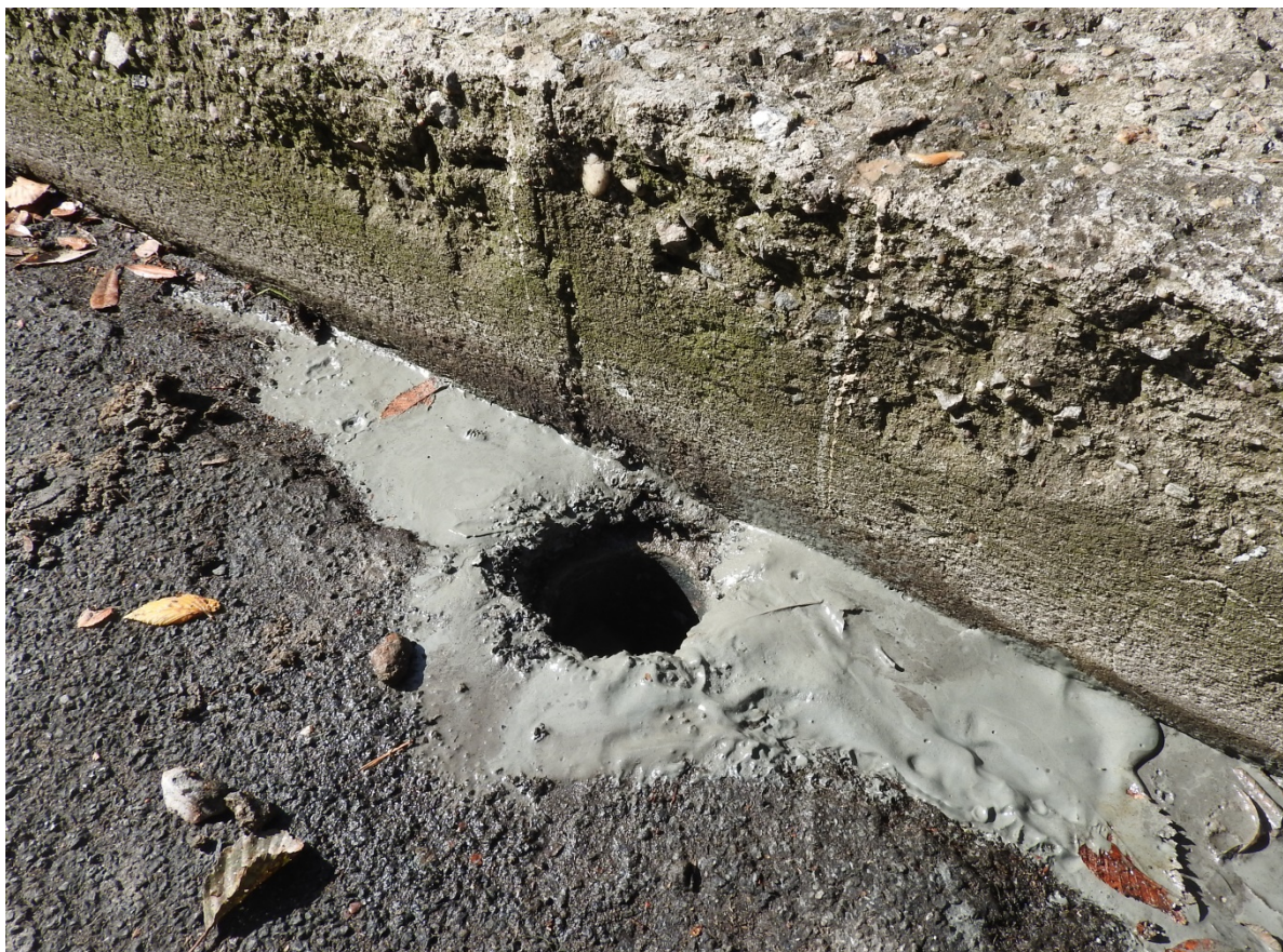
Obrázek č. 7: Jádrový vrt 04-V5 pro zjištění skladby vozovkového souvrství.
