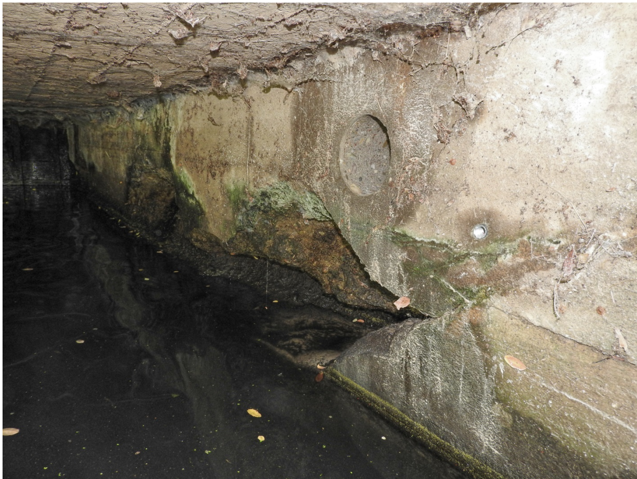
Obrázek č. 5: Pohled na levobřežní opěru s degradovaným betonem a kavernami.
