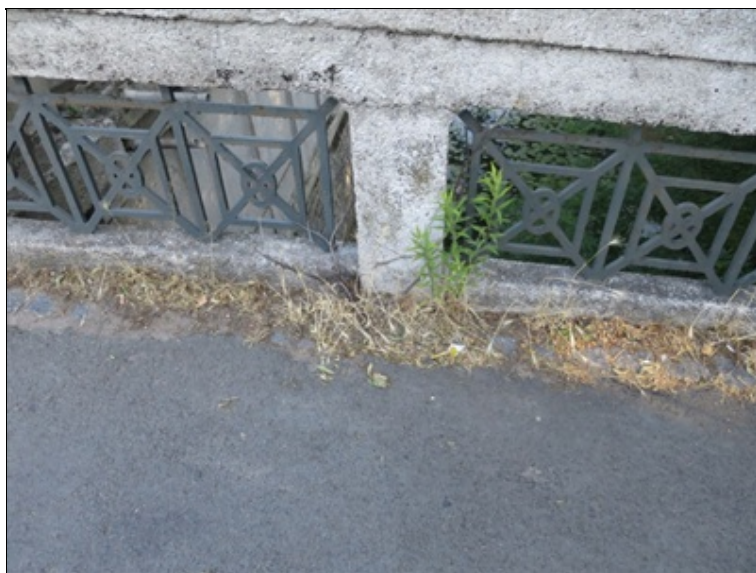
degradace betonu zábradlí, podél zábradlí je v chodníku uchycená vegetace
