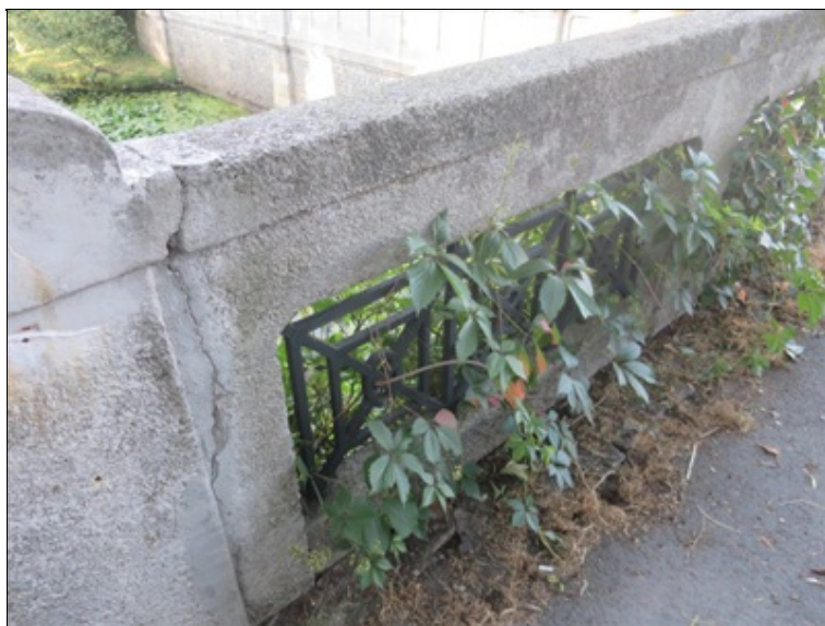
trhlina v zábradlí
