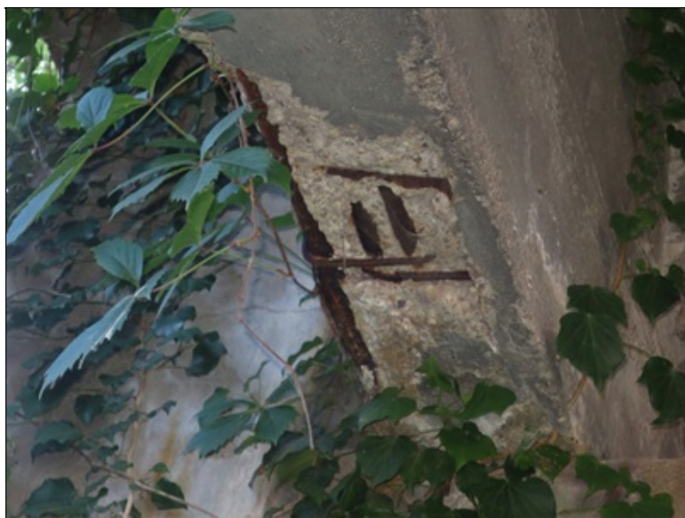
DTTO - detail poruch hlavního trámu
