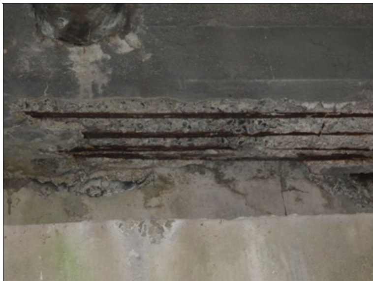
DTTO - detail poruch podporového příčnicku
