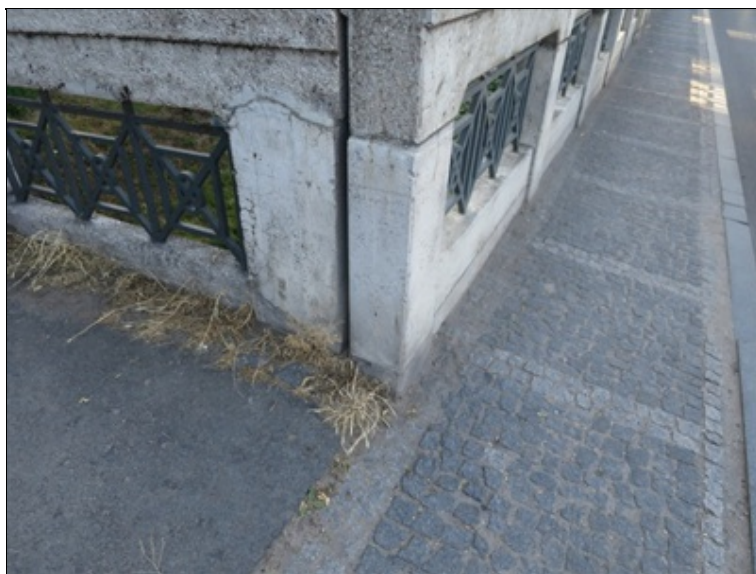
trhliny v betonové části zábradlí
