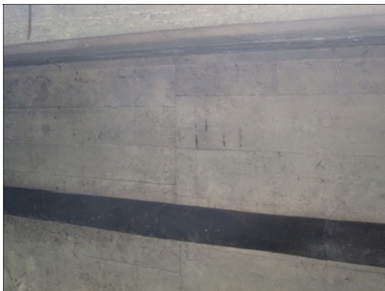
ojedinělá povrchově korodující výztuž desky mostovky v oblasti nulové tloušťky krycí vrstvy
