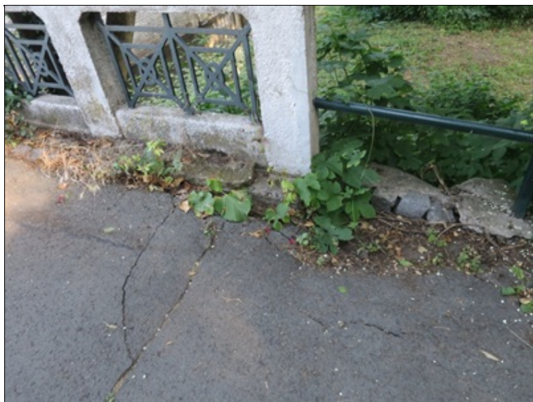
příčná trhлина v krytu chodníku
