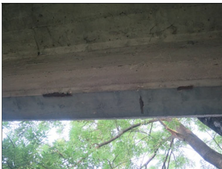
na líci NK je lokálně obnažena povrchově korodující výztuž v oblastech zcela nedostačující (spíše nulové) tloušťky krycí vrstvy
