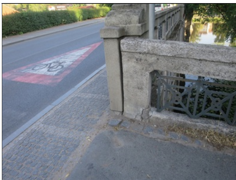
trhliny v betonové části zábradlí
