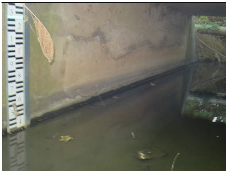
degradace betonu a ochranné omítky dříku opěry v úrovni kolísání hladiny vodoteče
