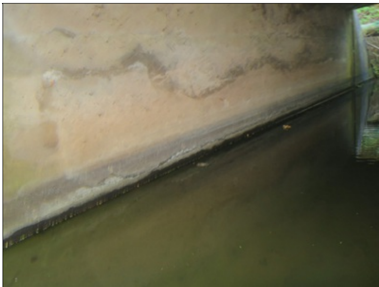
detail stavu opěry v úrovni kolísání hladiny vodoteče
