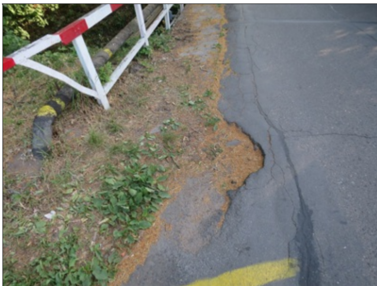
rozpad vozovky v oblasti krajnice
