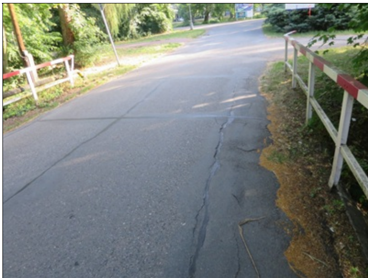
kryt vozovky je nerovný, hojně opravovaný
