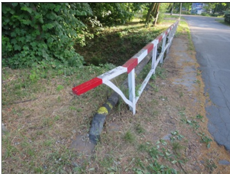
zábradlí je částečně deformované
