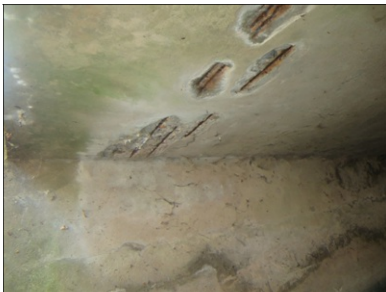
stopy po průsacích, odpadávání krycí vrstvy a intenzivní koroze výztuže v místech průsaků na spodním líci desky mostovky
