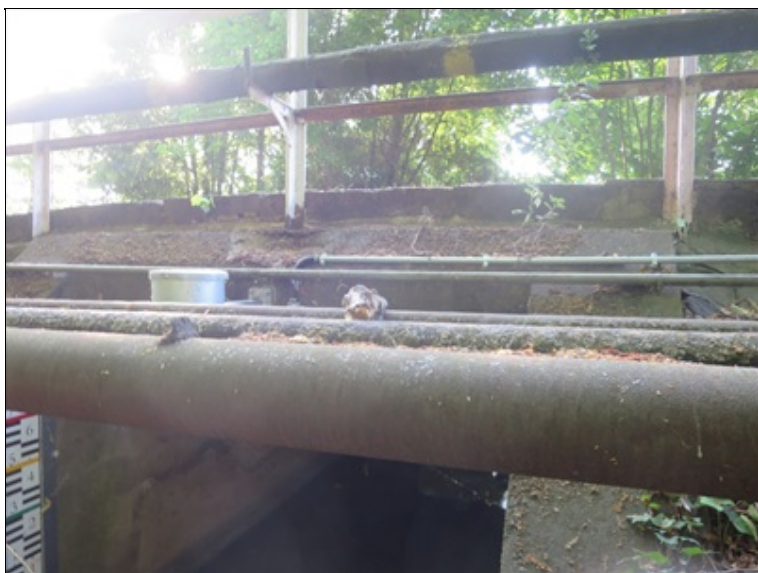
ke korozi zábradlí dochází zejména v oblasti kotvení do řím
