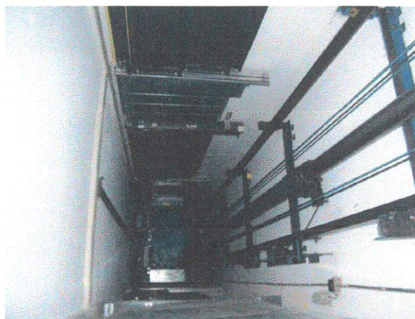
pohled do šachty výtahu s bočním vedením
