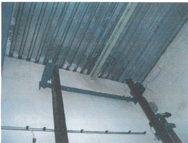
Strop výtahové šachty s montážním nosníkem
