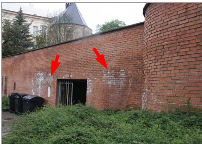
foto 39, 40: Vodou a mrazem poškozený líc zdiva jižní obvodové stěny pod terasou
