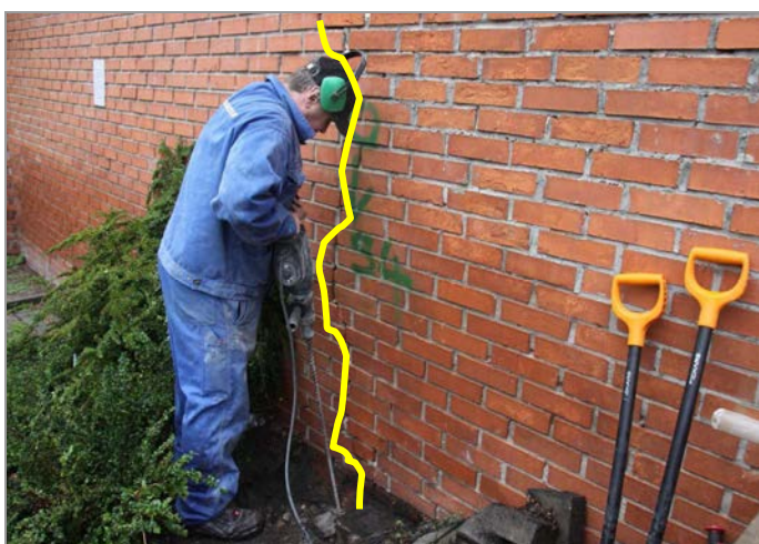
foto 53, 54: Ověřování základových podměrů jižní stěny kopanou sondou K-1 a vrtem V-4 v místě smykové trhliny
