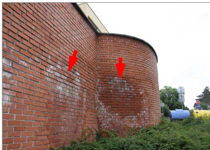
foto 39, 40: Vodou a mrazem poškozený líc zdiva jižní obvodové stěny pod terasou
