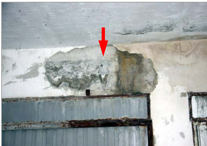
foto 21, 22: Strop a průvlaky haly garáží poškozené zatékáním z terasy
