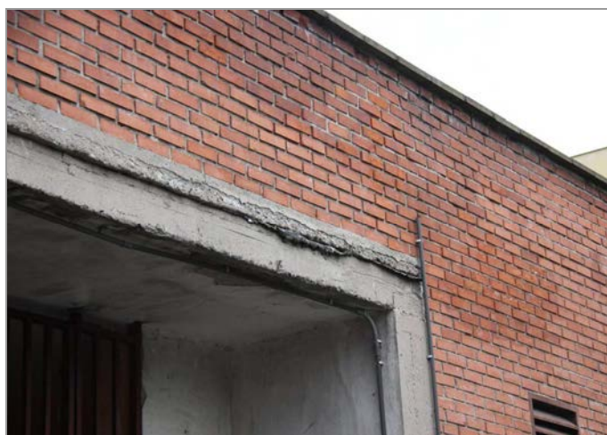
foto 41, 42: Odhalená a povrchově zkorodovaná výztuž překladu nad vjezdem do skladu
