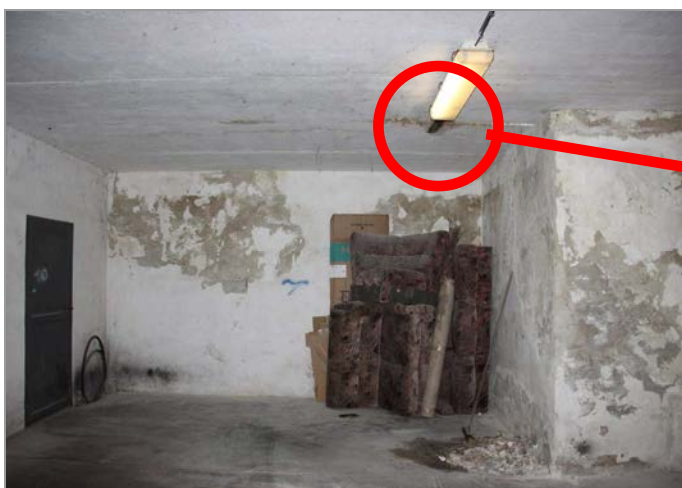
foto 11, 12: Pohled na místo průvrtu stropní konstrukce V-3 a plošnou sondu P-3 do stropní konstrukce haly garáží
