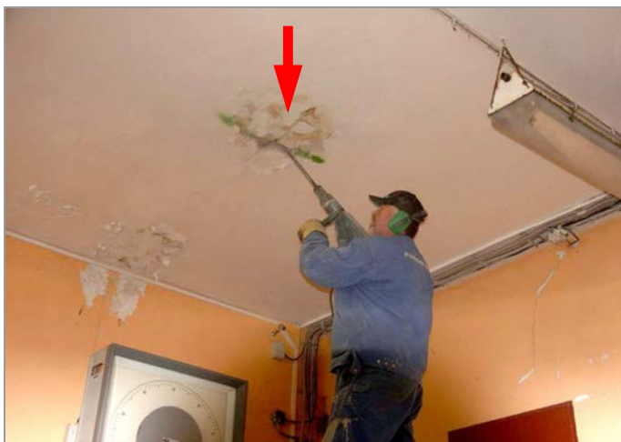
foto 25, 26: Realizace plošné sondy P-4 do stropní konstrukce skladu v místě zatékání z terasy
