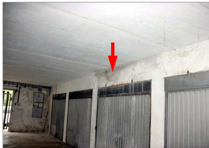
foto 21, 22: Strop a průvlaky haly garáží poškozené zatékáním z terasy
