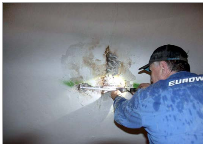
foto 25, 26: Realizace plošné sondy P-4 do stropní konstrukce skladu v místě zatékání z terasy
