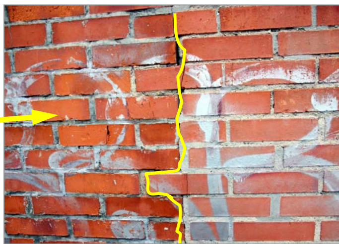
foto 49, 50: Smykové trhliny lícového zdiva jižní obvodové stěny pod terasou
