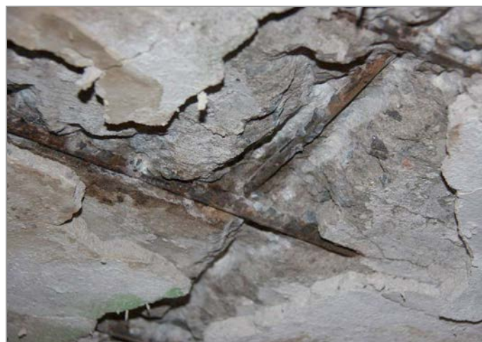
foto 27, 28: Vlivem zatékání z terasy koroze poškozená výztuž ŽB stropní desky v plošné sondě P-4
