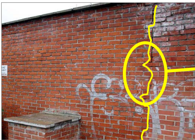
foto 49, 50: Smykové trhliny lícového zdiva jižní obvodové stěny pod terasou
