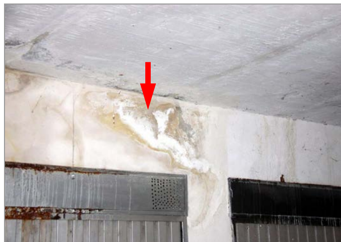
foto 19, 20: Stěny a průvlaky haly garáží poškozené zatékáním z terasy
