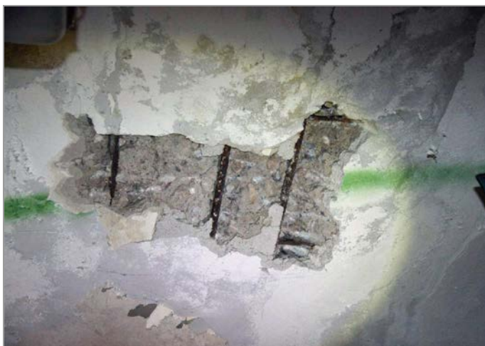
foto 31, 32: Vlivem zatékání z terasy korozí poškozená výztuž ŽB stropní desky v plošné sondě P-5
