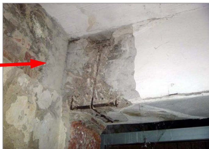
foto 17, 18: Zatékáním poškozená zadní stěna haly garáží a průvlak s odhalenou a korozí poškozenou výztuží
