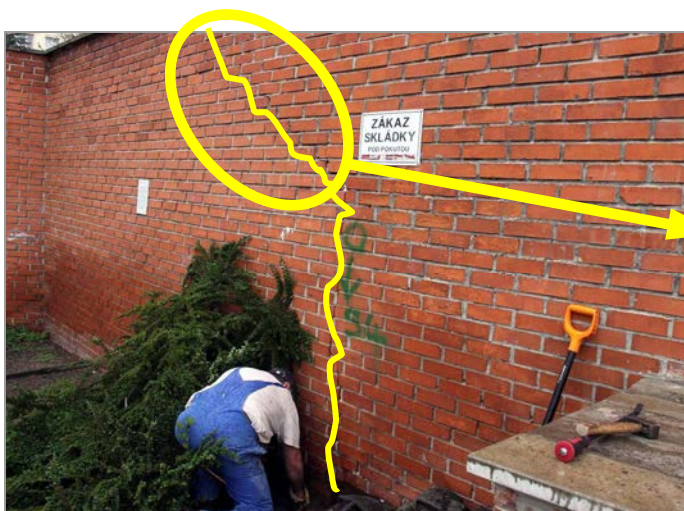
foto 51, 52: Smykové trhliny lícového zdiva jižní obvodové stěny pod terasou
