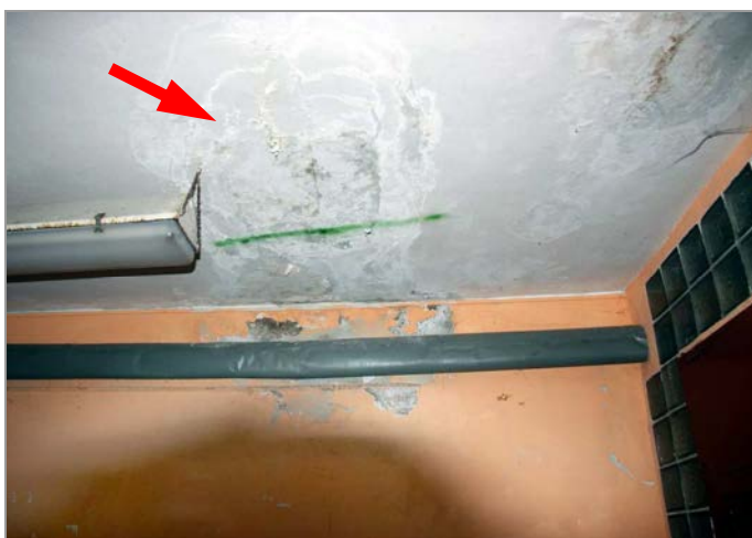
foto 29, 30: Realizace plošné sondy P-5 do stropní konstrukce skladu v místě zatékání z terasy
