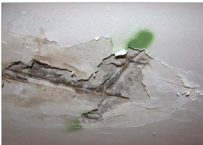
foto 27, 28: Vlivem zatékání z terasy koroze poškozená výztuž ŽB stropní desky v plošné sondě P-4
