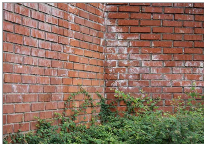
foto 45, 46: Detail vodou a mrazem poškozeného lícového zdiva jižní obvodové stěny pod terasou
