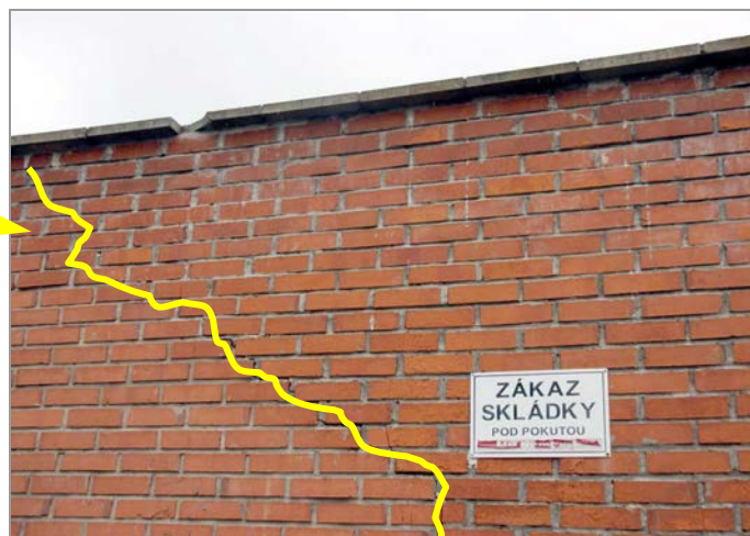
foto 51, 52: Smykové trhliny lícového zdiva jižní obvodové stěny pod terasou
