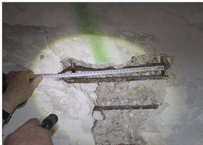
foto 31, 32: Vlivem zatékání z terasy korozí poškozená výztuž ŽB stropní desky v plošné sondě P-5
