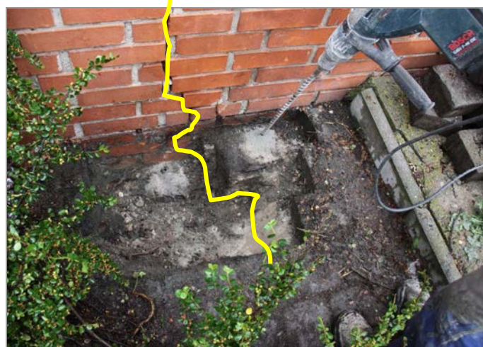
foto 53, 54: Ověřování základových podměrů jižní stěny kopanou sondou K-1 a vrtem V-4 v místě smykové trhliny
