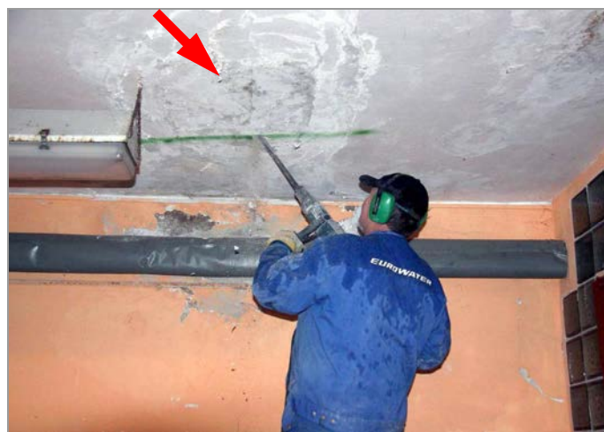
foto 29, 30: Realizace plošné sondy P-5 do stropní konstrukce skladu v místě zatékání z terasy
