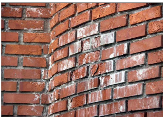
foto 47: Vodou a mrazem poškozené lícové zdivo
