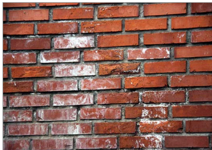
foto 43, 44: Detail vodou a mrazem poškozeného lícového zdiva jižní obvodové stěny pod terasou
