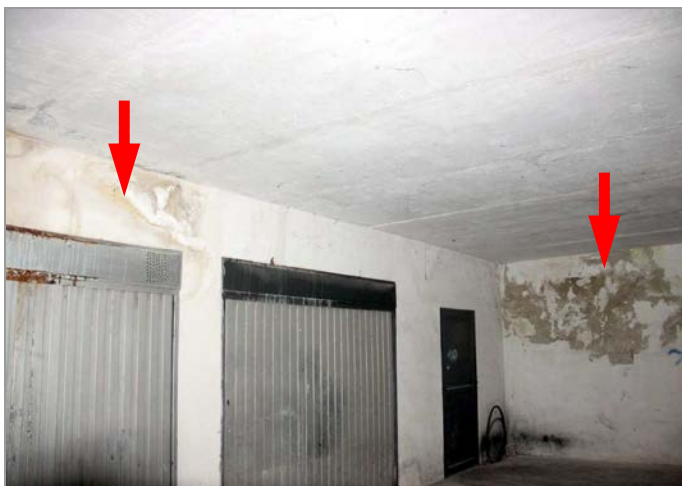
foto 19, 20: Stěny a průvlaky haly garáží poškozené zatékáním z terasy
