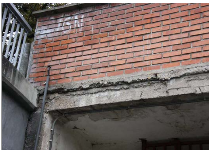
foto 41, 42: Odhalená a povrchově zkorodovaná výztuž překladu nad vjezdem do skladu
