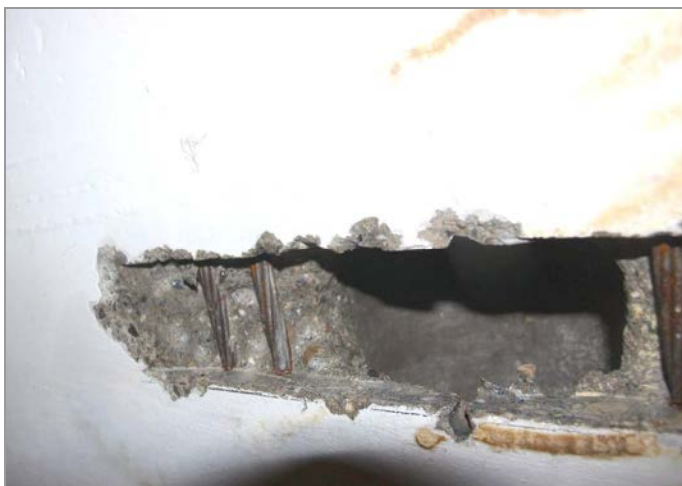
foto 13, 14: Detail výztuže předpjatých ŽB stropních panelů v sondě P-3 mezi dutinami resp. na styku panelů
