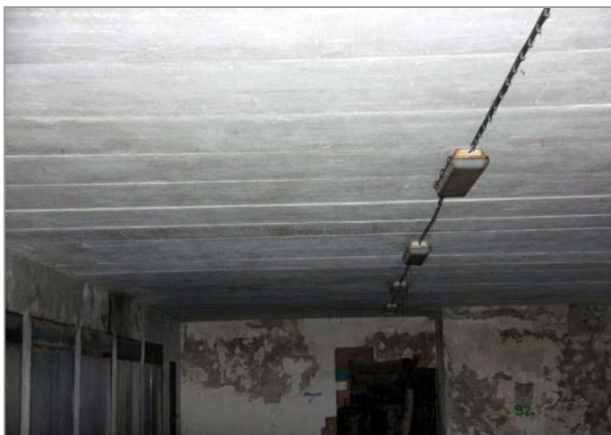
foto 9, 10: Detail zastropení haly garáží předpjatými ŽB panely skladebné šířky 1,20 m
