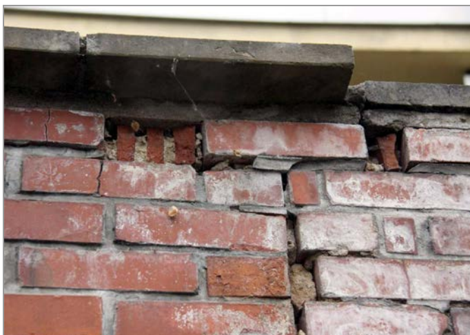
foto 43, 44: Detail vodou a mrazem poškozeného lícového zdiva jižní obvodové stěny pod terasou
