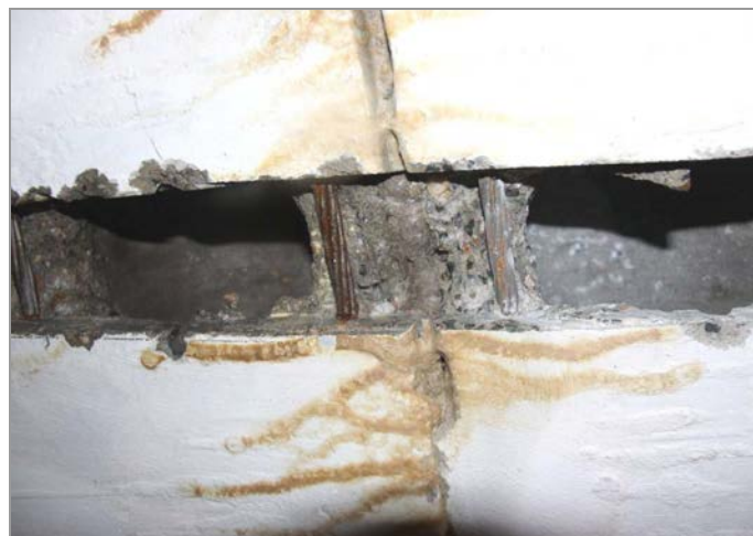
foto 13, 14: Detail výztuže předpjatých ŽB stropních panelů v sondě P-3 mezi dutinami resp. na styku panelů
