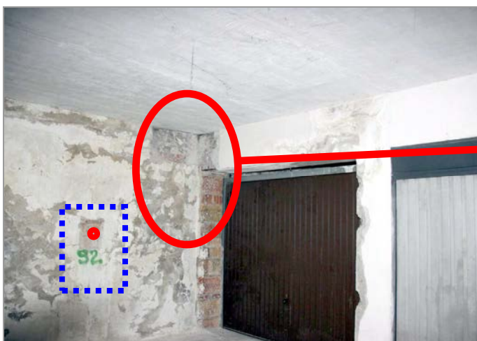
foto 17, 18: Zatékáním poškozená zadní stěna haly garáží a průvlak s odhalenou a korozí poškozenou výztuží
