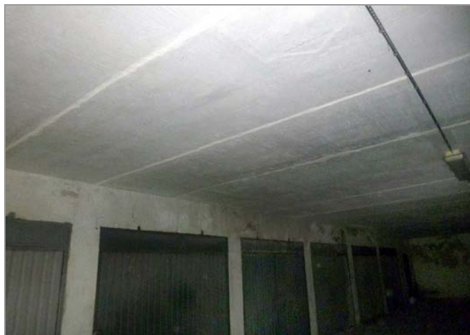
foto 9, 10: Detail zastropení haly garáží předpjatými ŽB panely skladebné šířky 1,20 m
