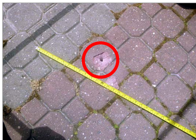
foto 5, 6: Místo svislého průvrtu V-3 pro ověření skladby terasy a zastropení haly garáží
