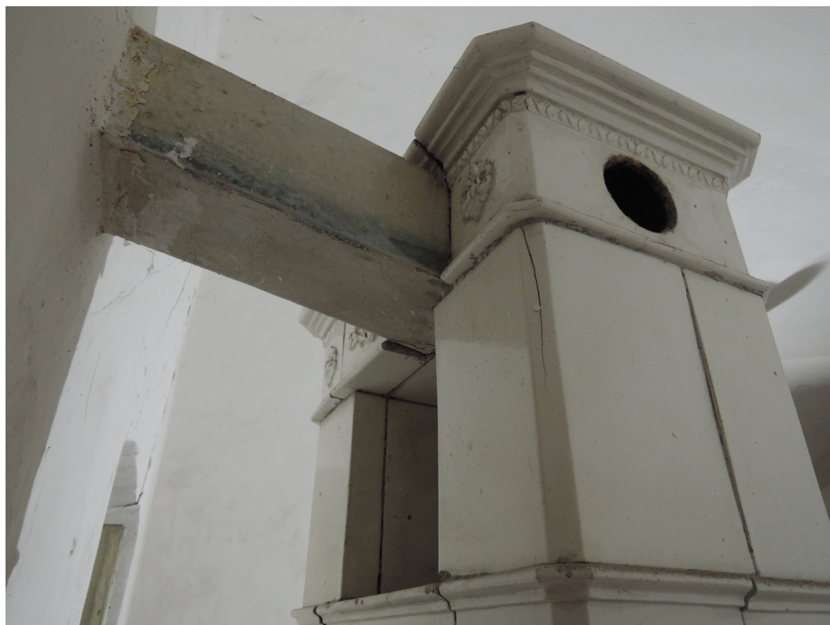
Kamna KA02 – dokumentace stávajícího stavu a poškození
