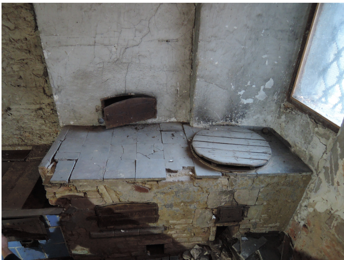
Kamna KA05 – zděná část s pecí na chleba a kotlem Celé těleso je rozpraskané, omítka opadaná
