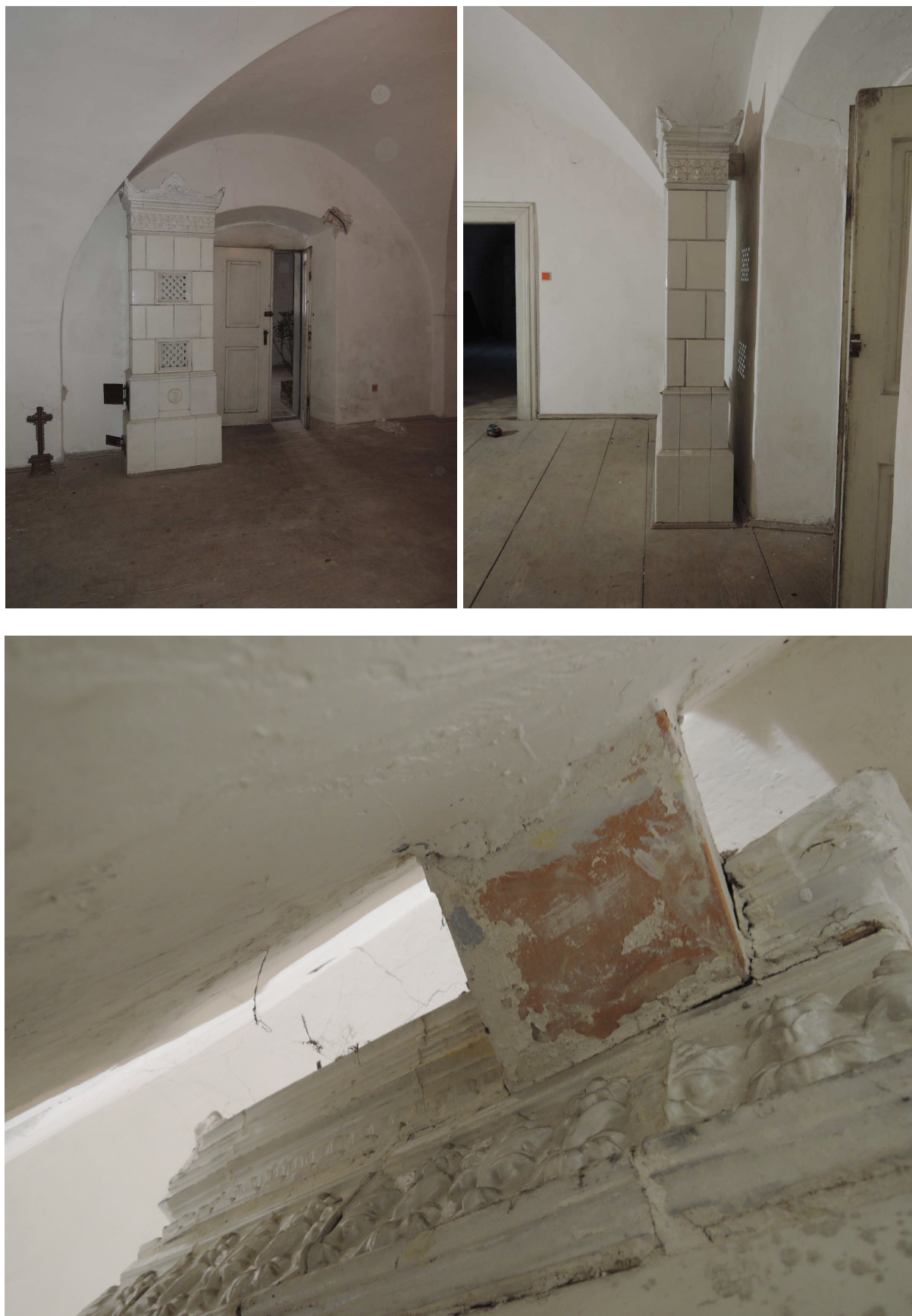
Kamna KA01 – dokumentace stávajícího stavu a poškození
