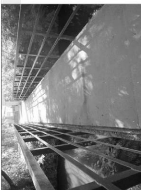
kryt chodníku je oděmovaný s třtinami v místech příčných spár mezi přelávkami
