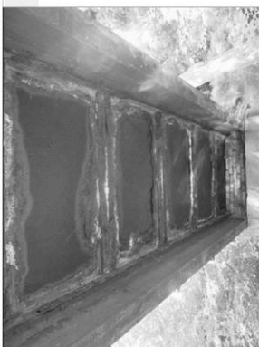
intenzivní korozní předtlu a uhlíkové přetřepání mostovky
