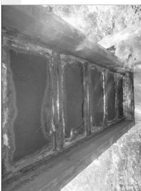
intenzivní koroze prachu a uhlíku prafabrikátu mostovky
