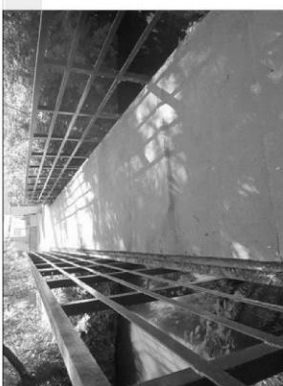
kryt chodníku je odformovaný s třískami v místech příčných spár mezi prafabrikáty
