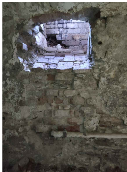
Pohled na stávající otvor
