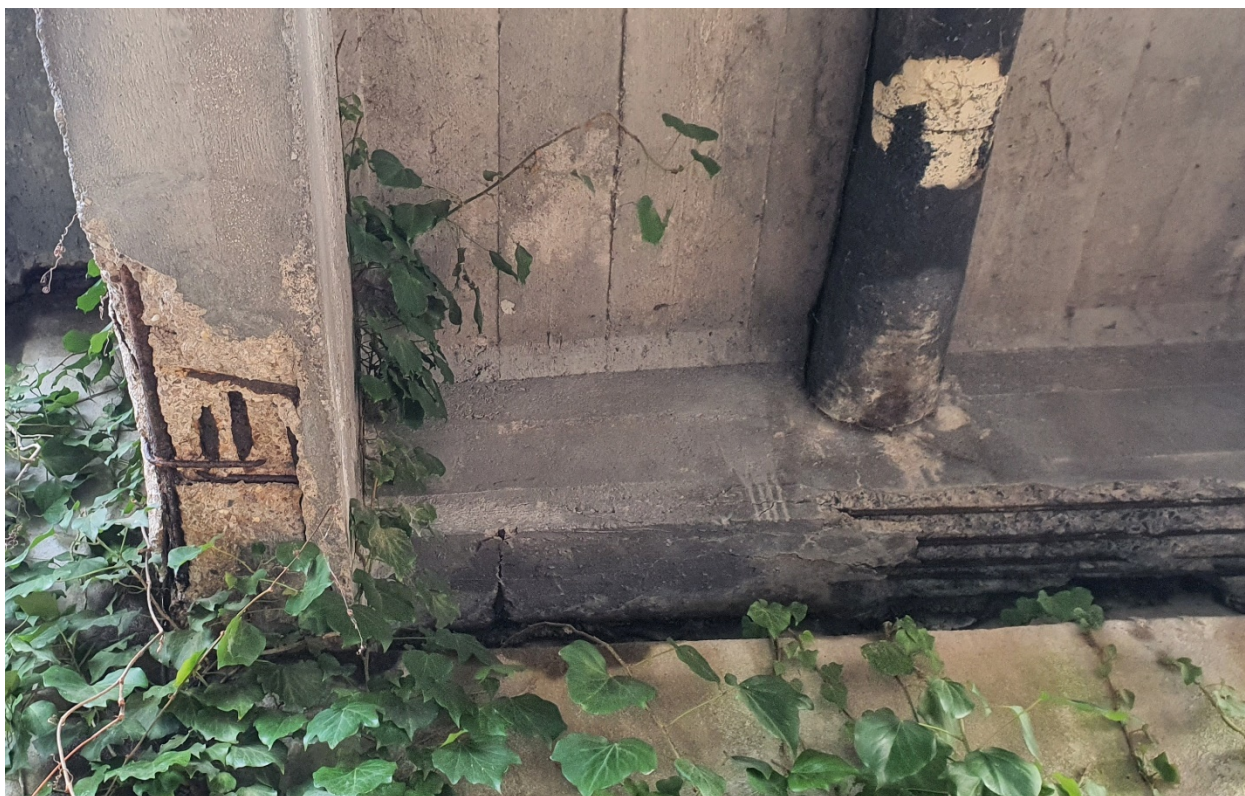
Obrázek č. 5: Místa odhalené výztuže nad opěrou v ulici Na Ostrově (fotografická dokumentace pořízená statikem Ing. D. Marečkem v lednu 2020).
