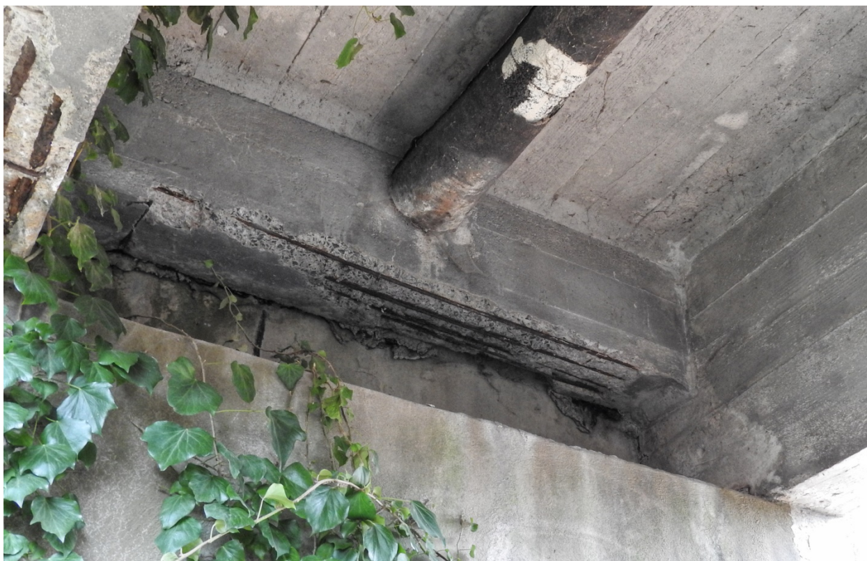
Obrázek č. 8: Propadání asfaltobetonu za krajním příčným trámem nad opěrou v ulici Na Ostrově.
