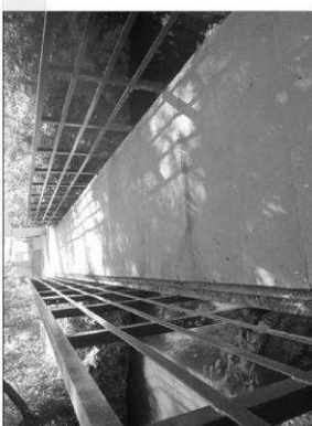
kryt chodníku je odformovaný s třílami v místech příčných spár mezi přelávkami
