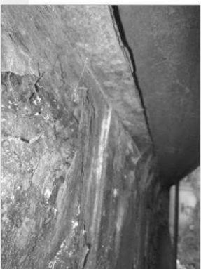
detail spár mezi prefabrikáty a ocelovými hlavními nosníky
