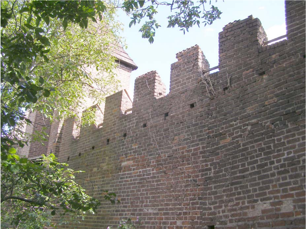
13. Vnitřní strana hradeb - severní část
