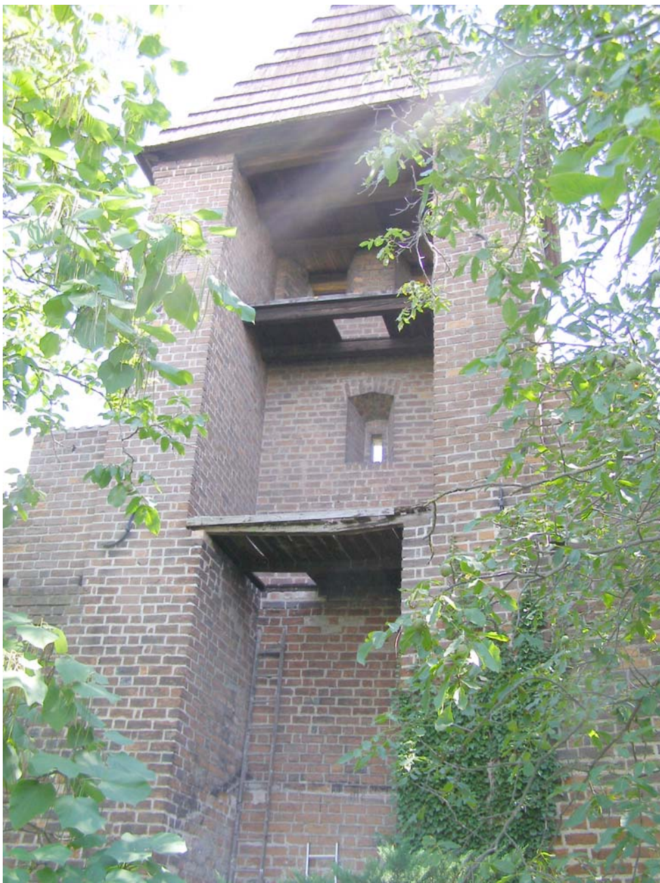
9. Vnitřní strana hradeb - interiér severní věže
