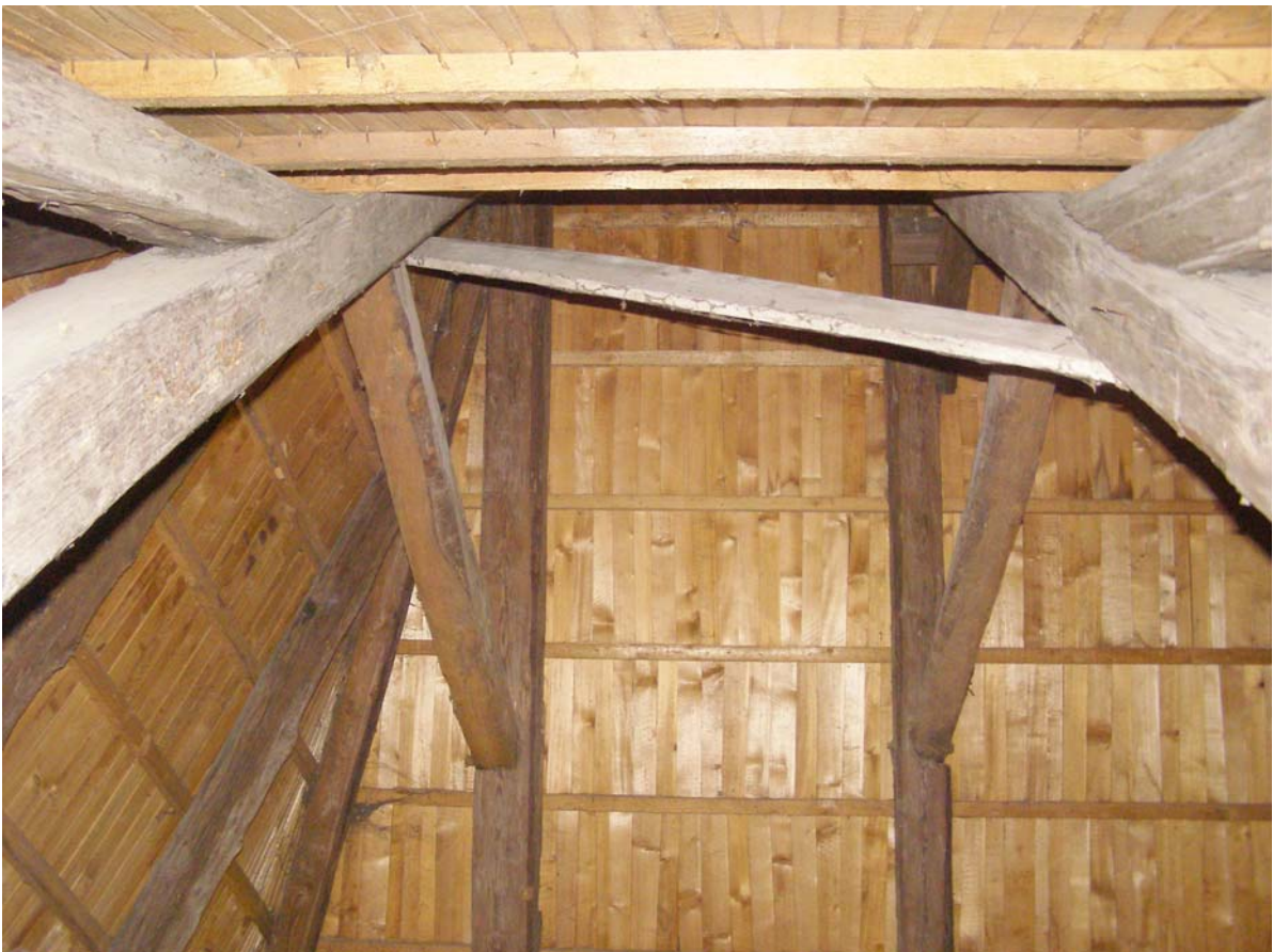
20. Krov věže "Kaplanka"
