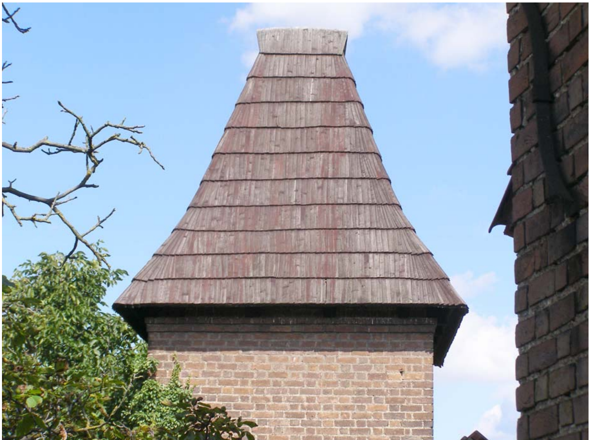
12. Střecha jižní věže
