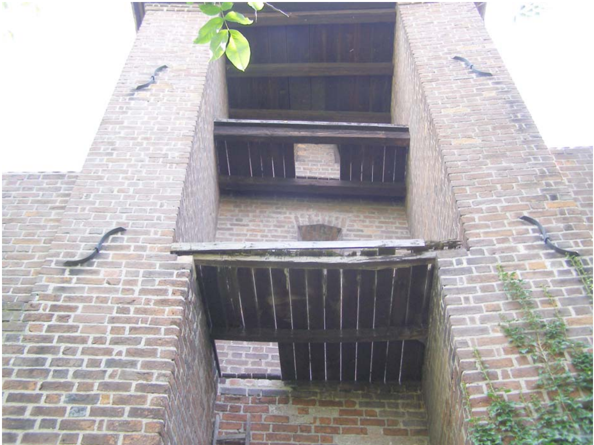
11. Vnitřní strana hradeb - interiér severní věže
