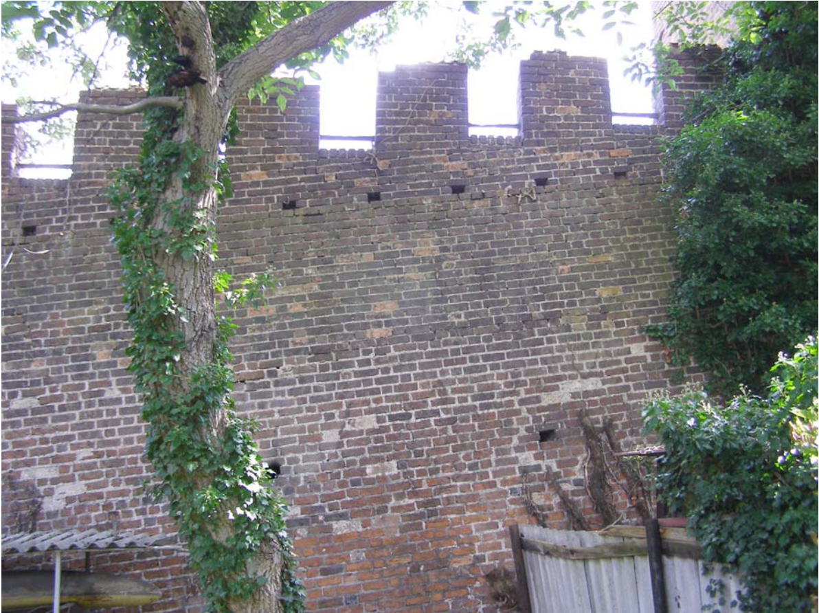
15. Vnitřní strana hradeb - jižní část
