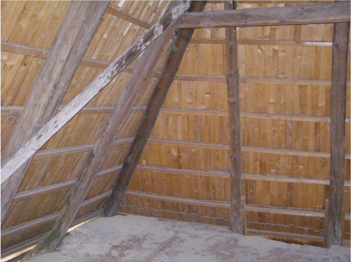
19. Krov věže "Kaplanka"
