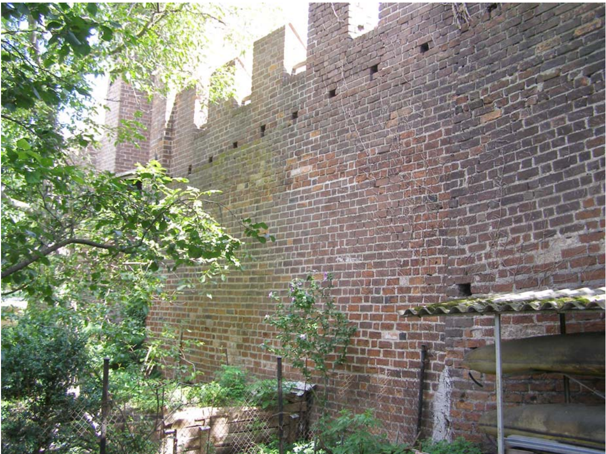
16. Vnitřní strana hradeb - severní část
