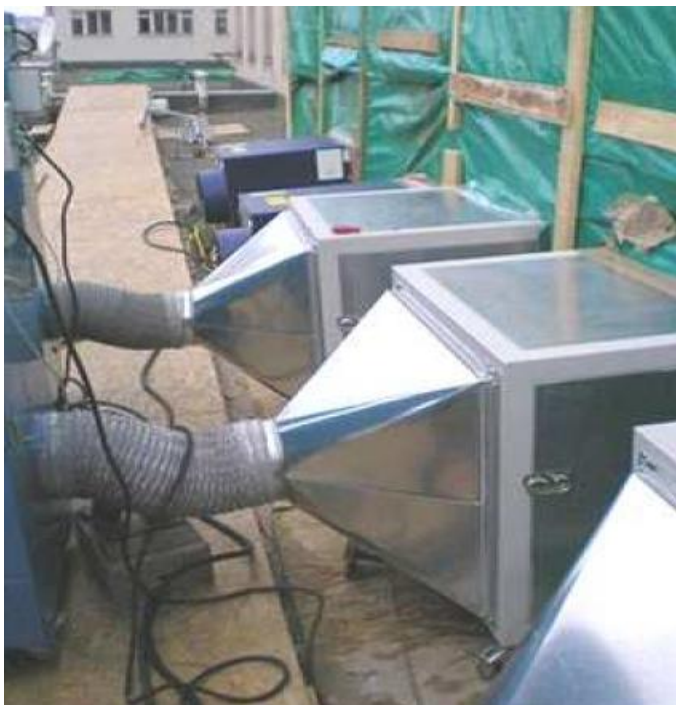
Obr. č. 6 – Uzavřené KP se zapojenými odsávacími jednotkami s HEPA filtry.
