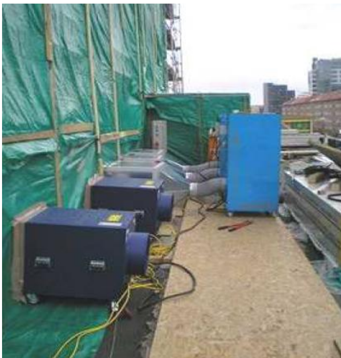
Obr. č. 6 – Uzavřené KP se zapojenými odsávacími jednotkami s HEPA filtry.
