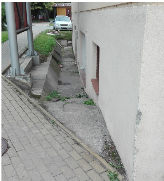
Nároží objektu A a průběh okapového chodníku v prostoru pod spojovací chodbou. V části betonová zámková dlažba.
