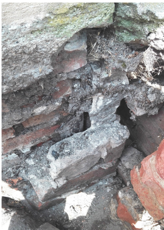
Nároží objektu, s viditelnou přizdívkou z CP, která slouží k uchycení hydroizolace.
