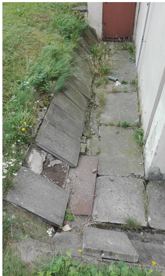
Poškozená dlažba okapového chodníku s revizním otvorem drenážní kanalizace (překrvtý plechem).
