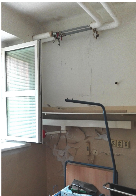
Rozhraní objektu (pavilonu) A a B – odlupující se malba na stěně.
