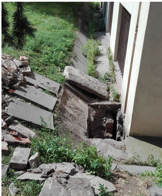
Foto provedené sondy v nároží objektu A.
