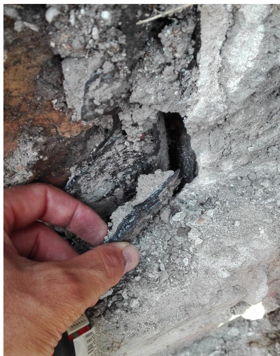
Detailní foto stejného místa, odlupující se hydroizolace.
