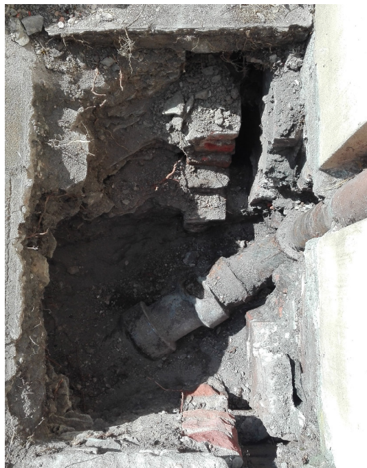
Viditelné obě původní přizdívky se vzduchovou mezerou. Dešťová kanalizace je v tomto místě prasklá.
